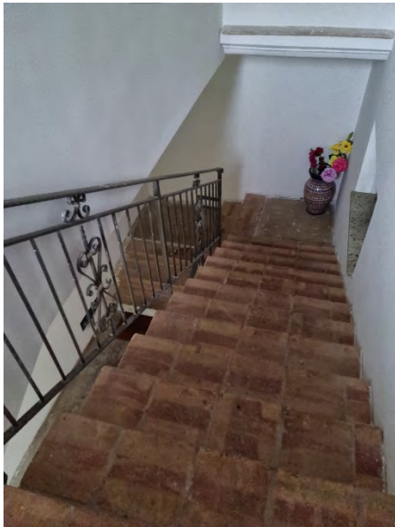
Scala interna di collegamento
