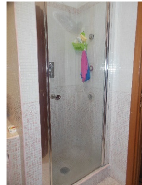
Bagno al piano primo
