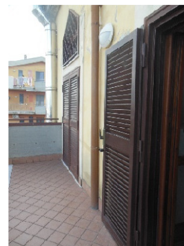
Balcone lato nord
