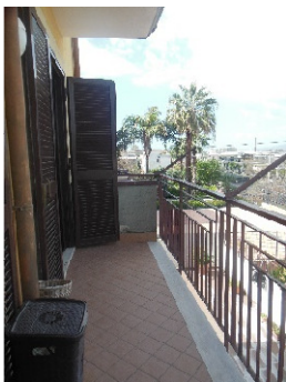
Balconata lato nord
