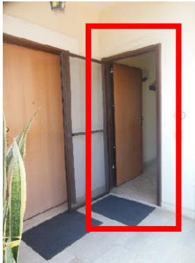
Ballatoio esterno al piano primo
