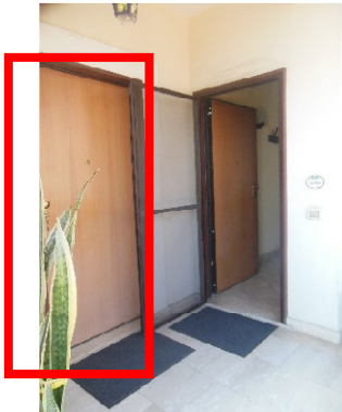
Ballatoio esterno al piano primo
