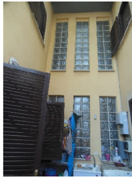
Parete vetrate fisse lato est
