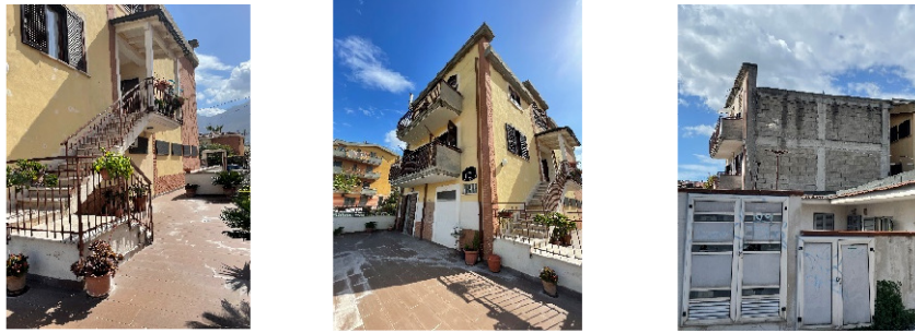
Viste esterne fabbricato da Via Santa Lucia
