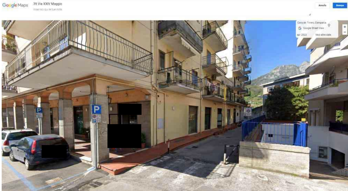
Angolo tra Via XXIV Maggio e Viale condominiale
