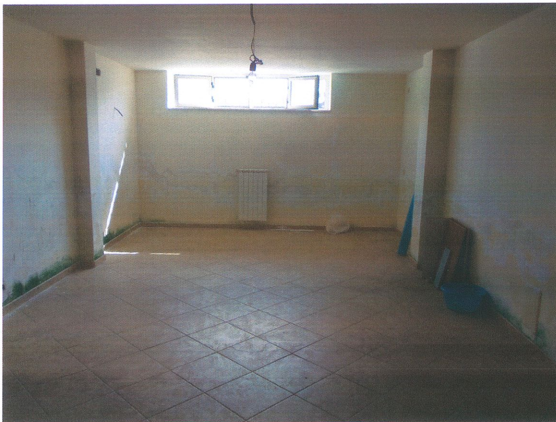
Foto 6 – Cantina al piano Seminterrato
