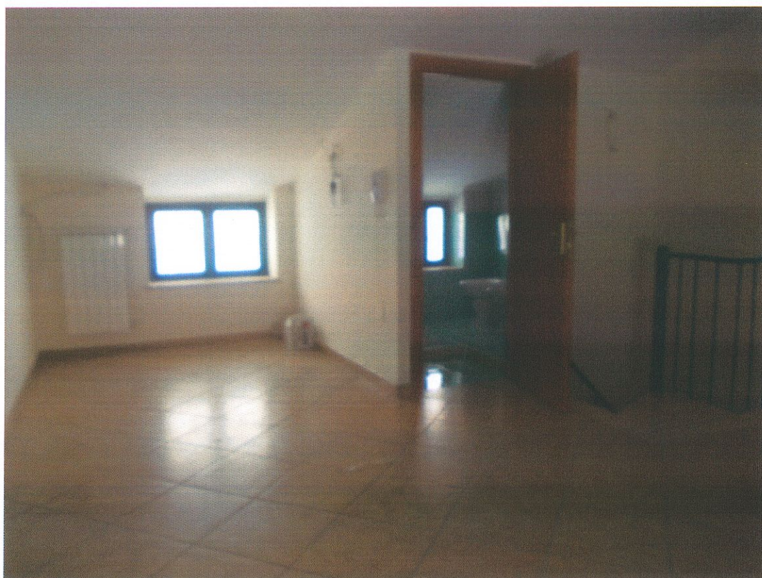
Foto 14 – Soffitta non abitabile al piano Sottotetto
