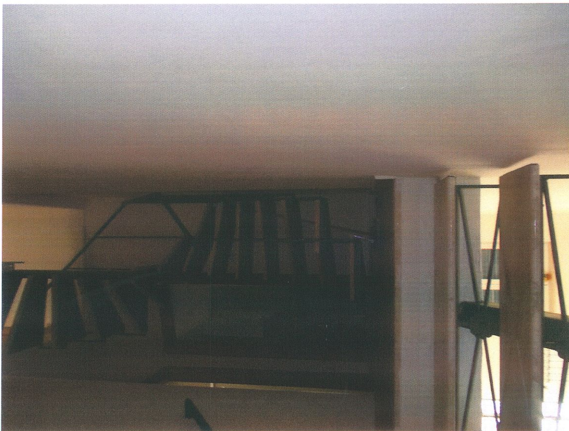
Foto 10 – Corridoio al piano Primo con scala di accesso al piano Sottotetto
