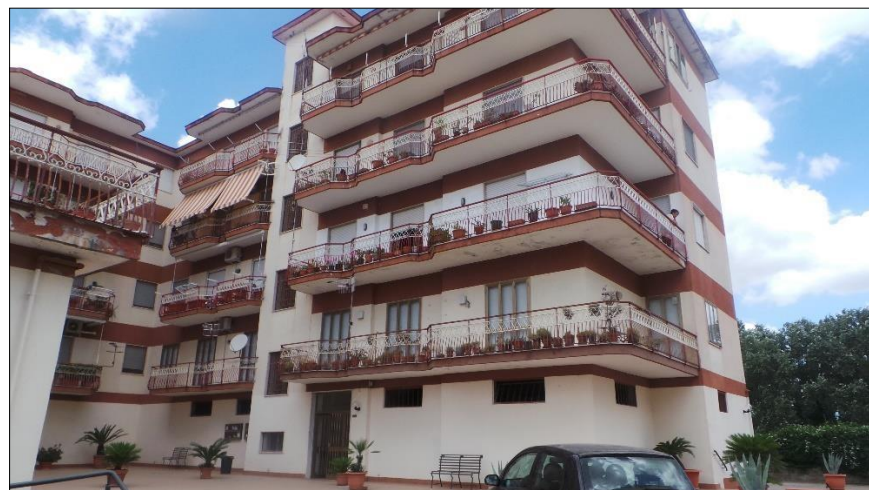
Ingresso fabbricato, scala B
