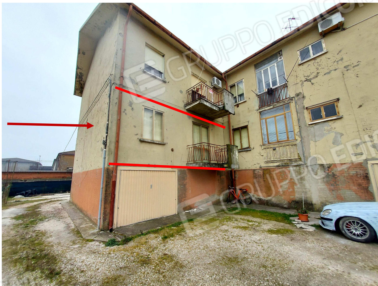
FACCIATA LATERALE (Viale della Rinascita)
