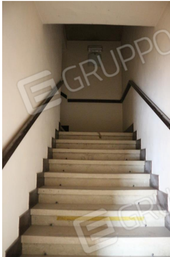
FOTO n°15. - visione scala di accesso al piano primo – LOTTO 9.3
