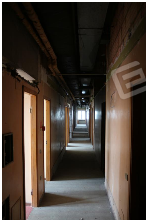
FOTO n°16. - visione interna – LOTTO 9.3
