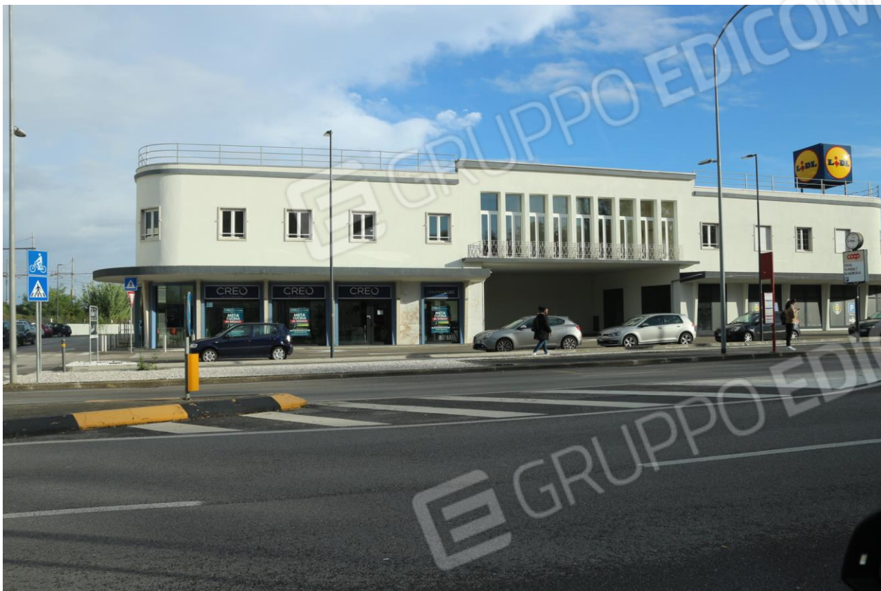
FOTO n°11. - visione esterna – LOTTO 9.3
