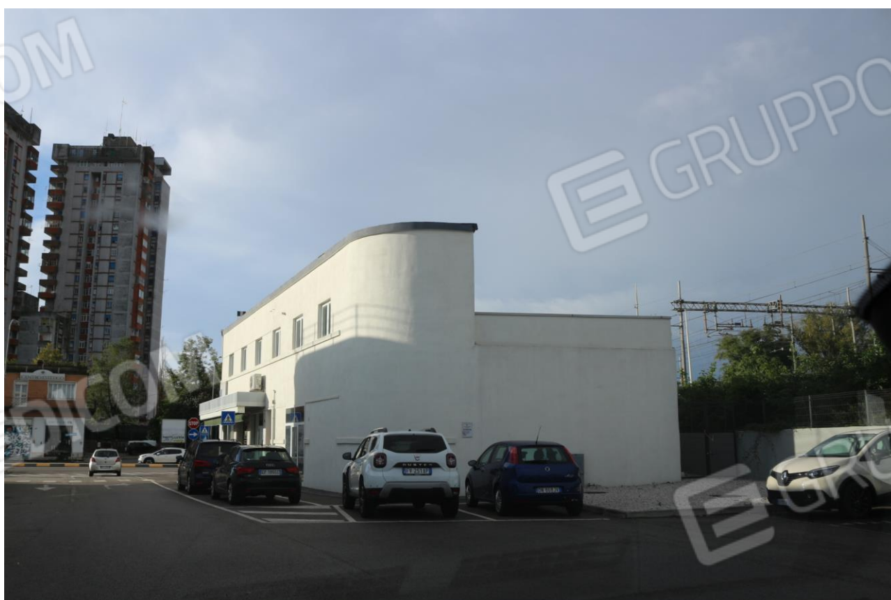
FOTO n°2. - visione esterna – LOTTO 9.1
