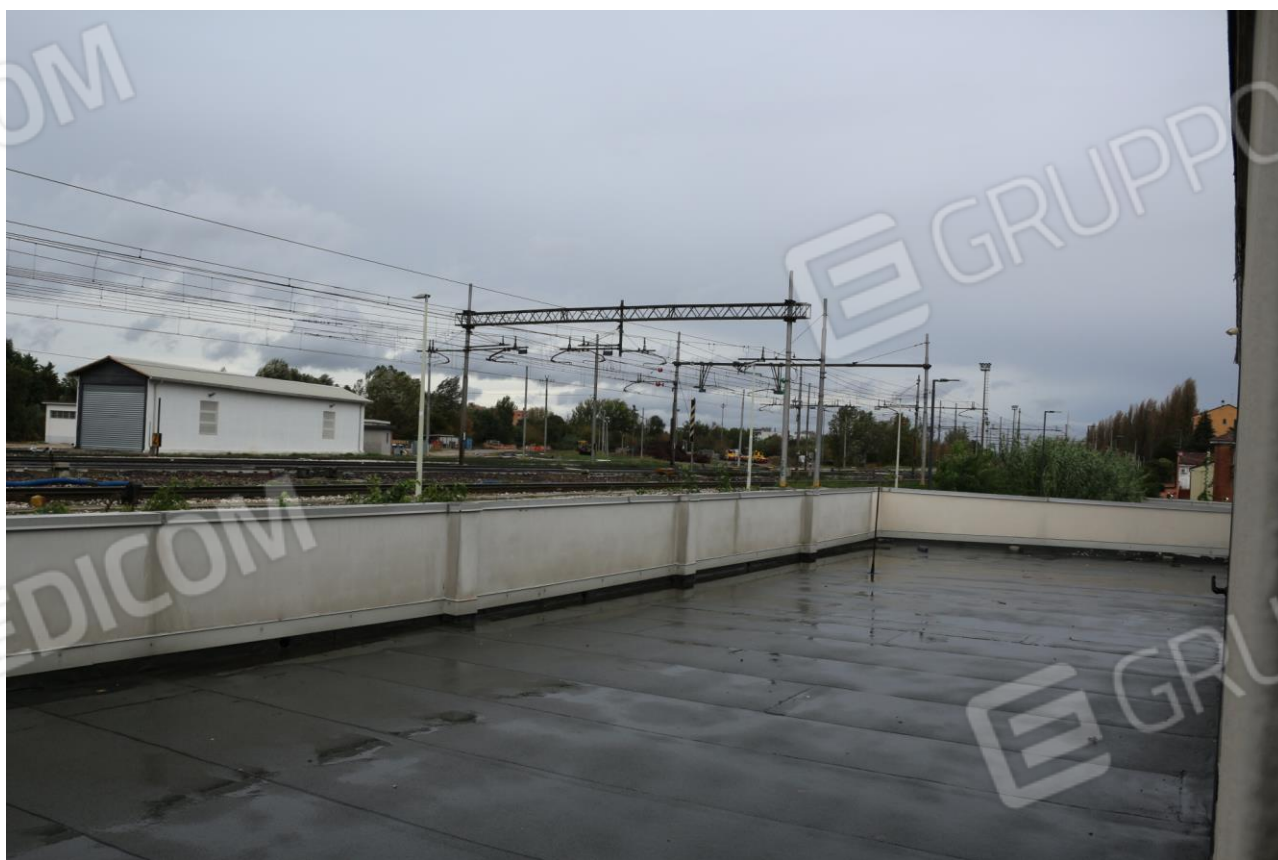
FOTO n°10. - visione lastrico solare – LOTTO 9.1
