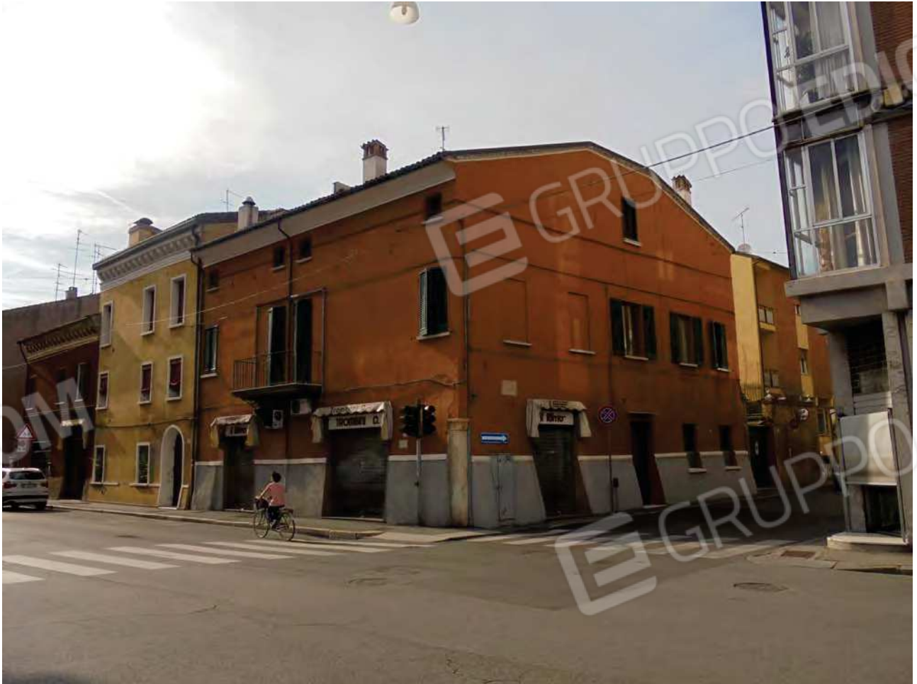
Foto 2. Prospetto sud -est . Vista da Corso Porta Po.
