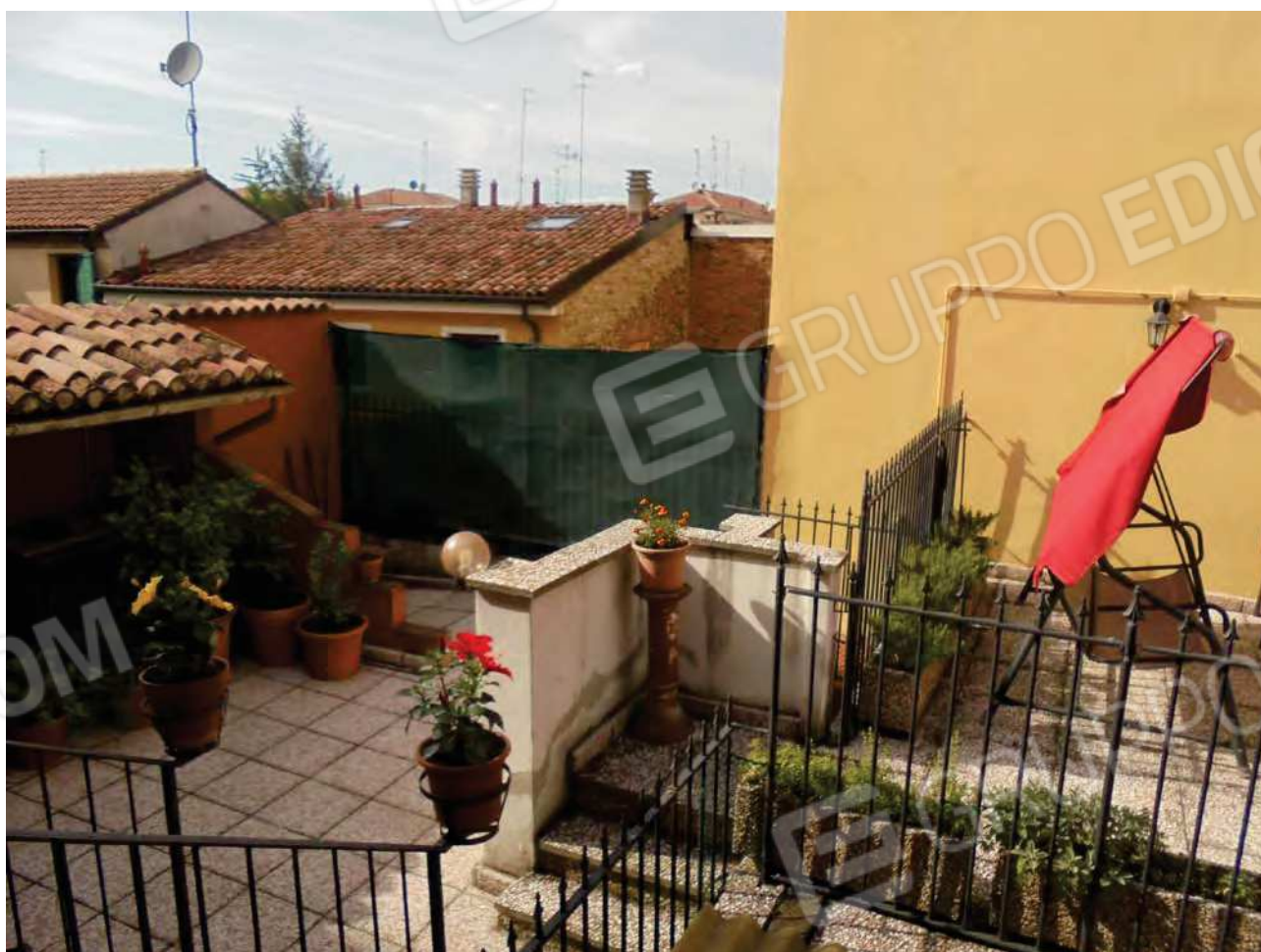
Foto 29. Particolare terrazza comune.
