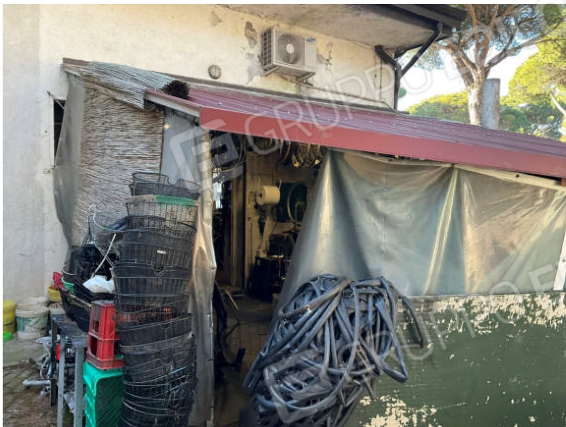
Tettoia su area bcnc mapp. 2505 parte
