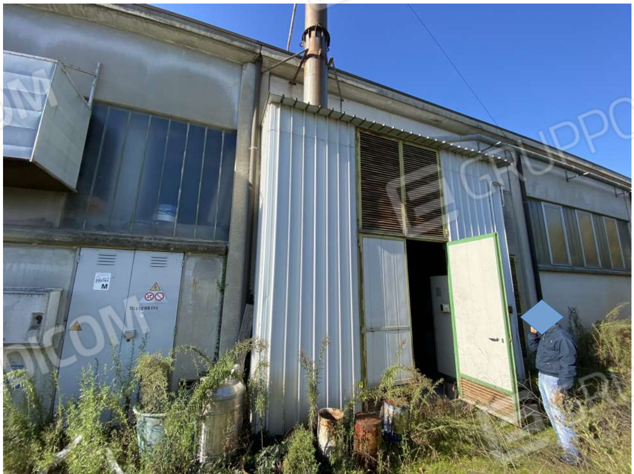
ingresso centrale termica dal prospetto laterale
