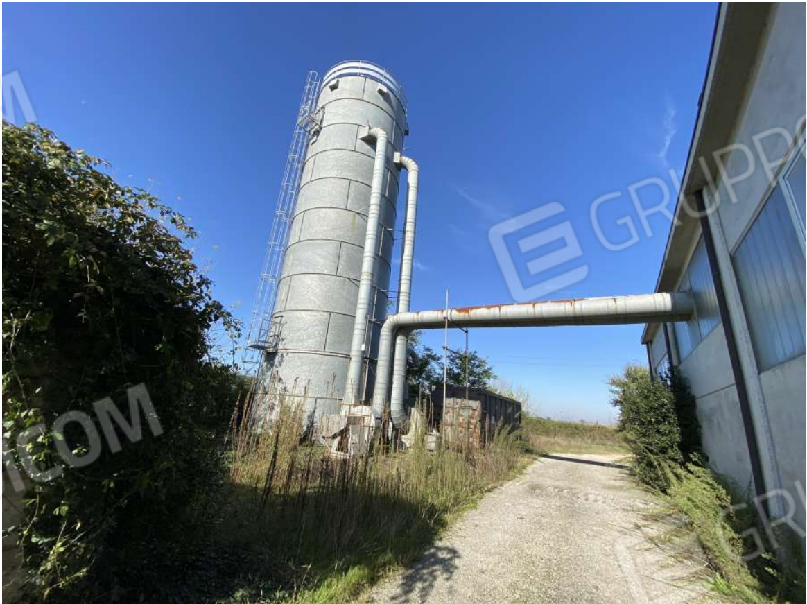
silos di raccolta polveri di legno (non ricompreso in asta)
