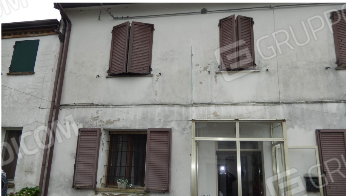
PROSPETTO PRINCIPALE (EST) PROSPICIENTE SU CORTE COMUNE
