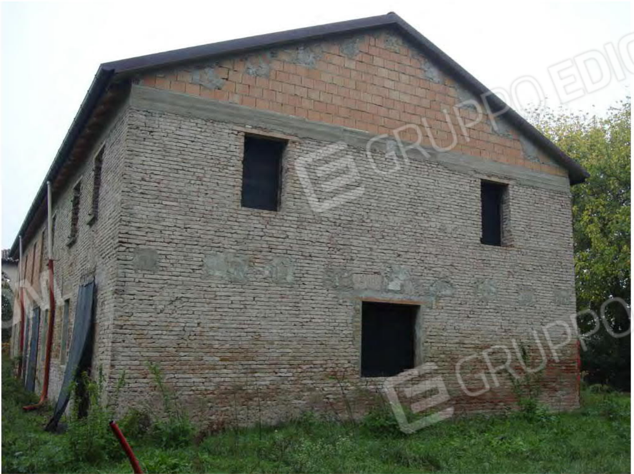
Foto 24. Mapp. 119. Prospetto Sud-Ovest.
