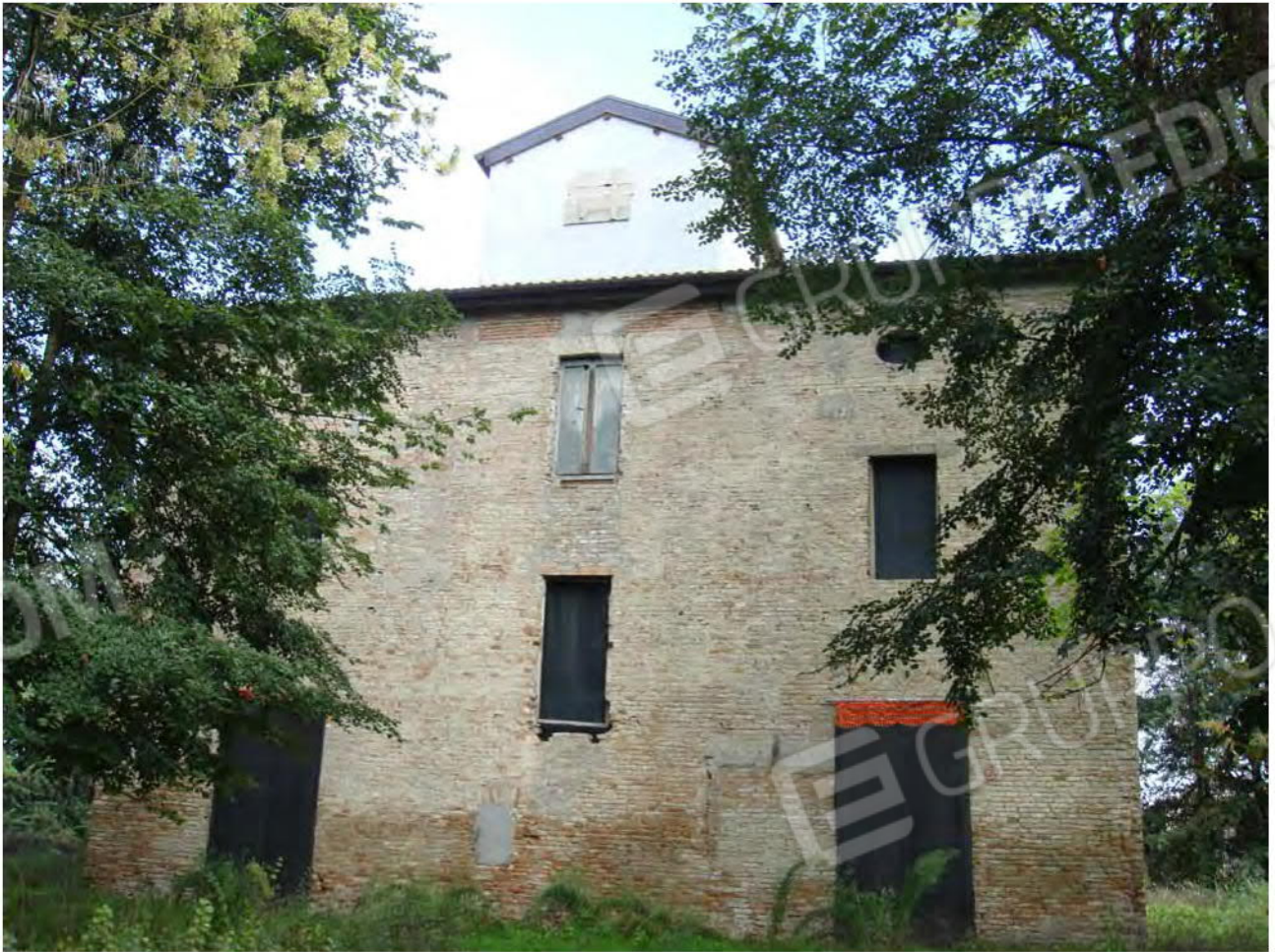
Foto 9. Mapp. 23. Prospetto Sud-Ovest.
