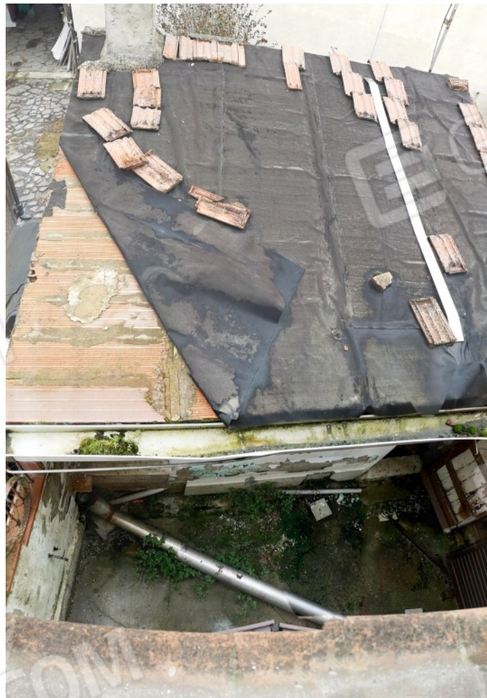
COPERTURA RIPOSTIGLIO ESTERNO
