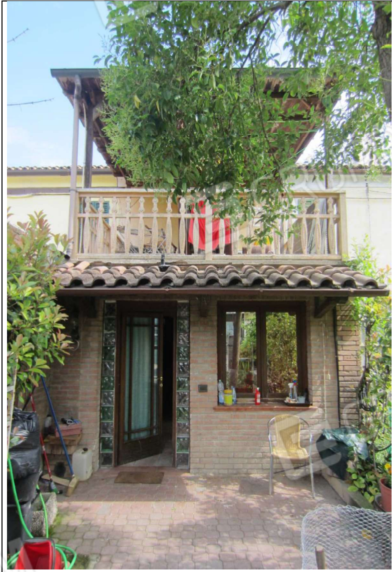
PROSPETTO LATO STRADA
