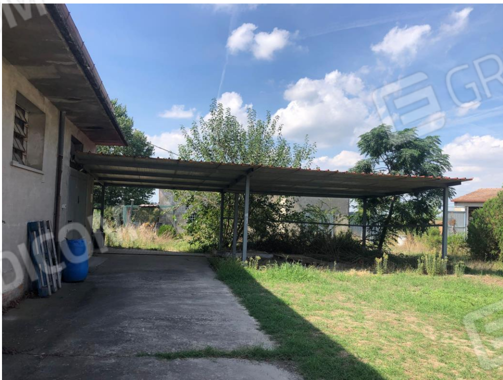
FOTO 23 – TETTOIA SU CORTE COMUNE
