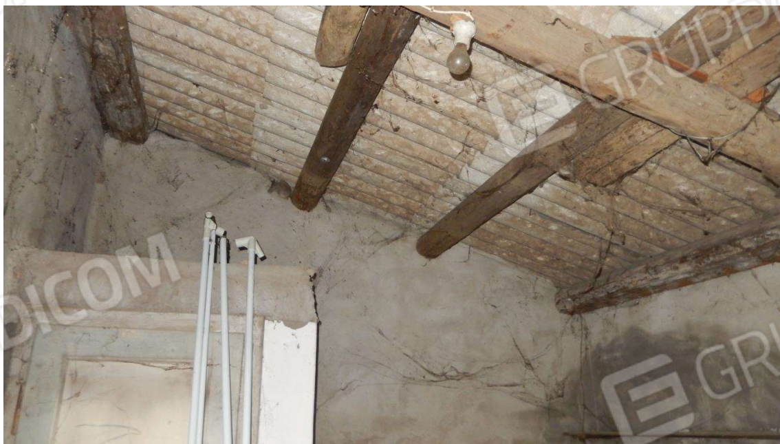
PARTICOLARE PROSERVIZIO I CON LATRINA
