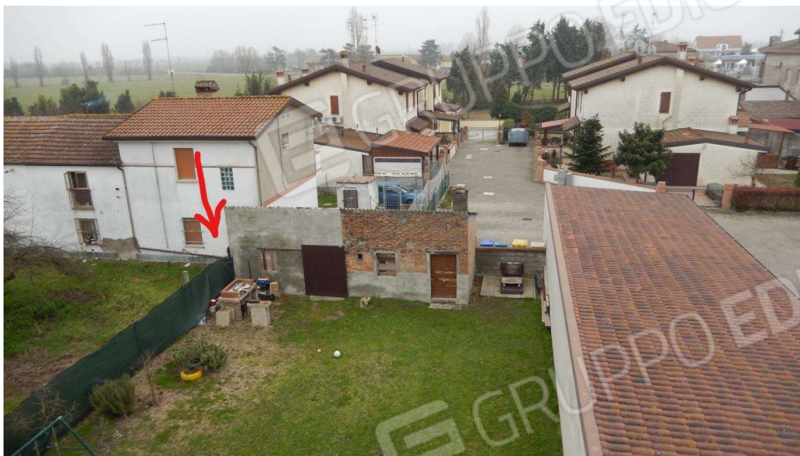
VISTA DA P.2. SU CORTE INTERNA (LATO EST) CONFINE SEGNATO DA VERIFICARE
