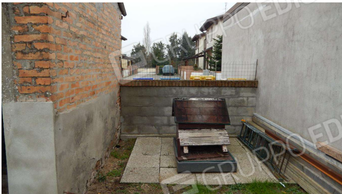
PARTICOLARE DOVE ERA PRESISTENTE APERTURA PASSO CARRABILE (EST), ORA MURATO E RIAPERTO SU LATO SUD
