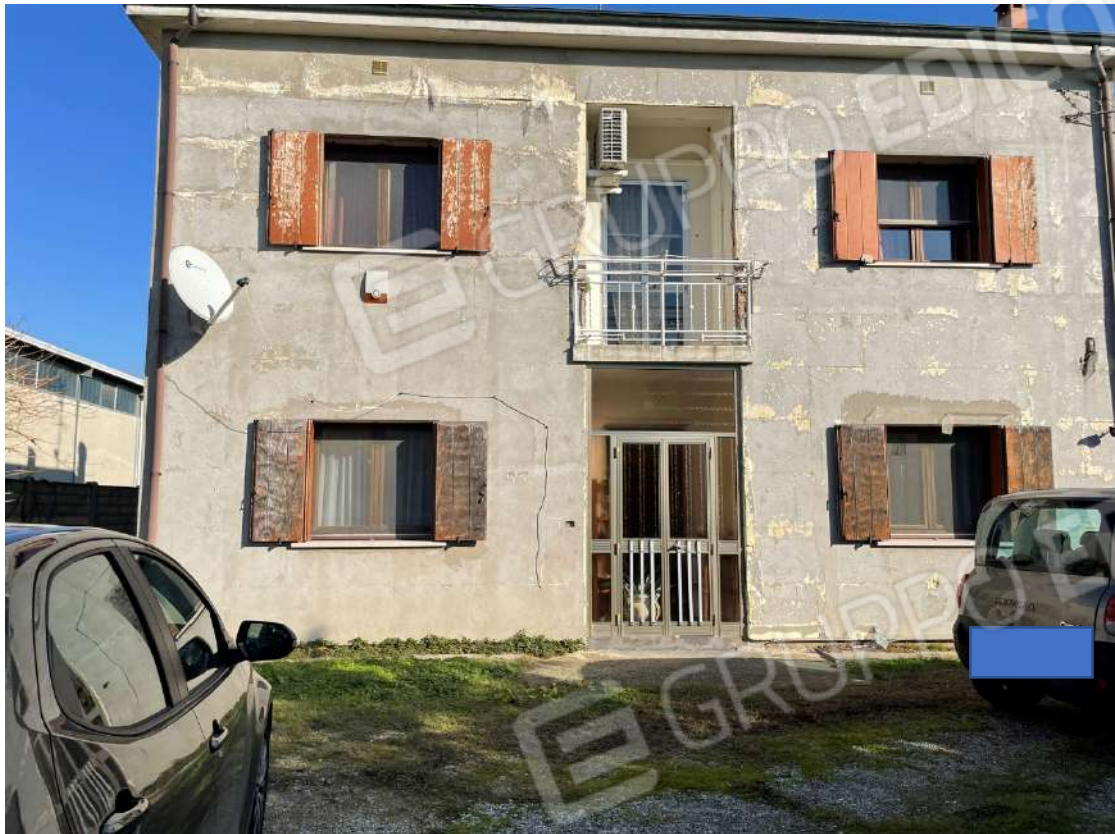
Prospetto principale lato est
