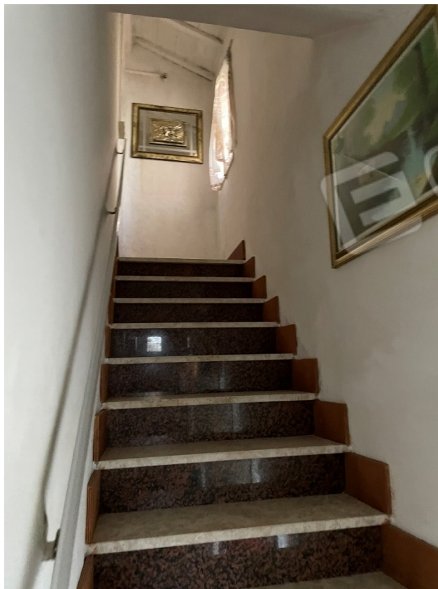
SCALE DI COLLEGAMENTO AL P1
