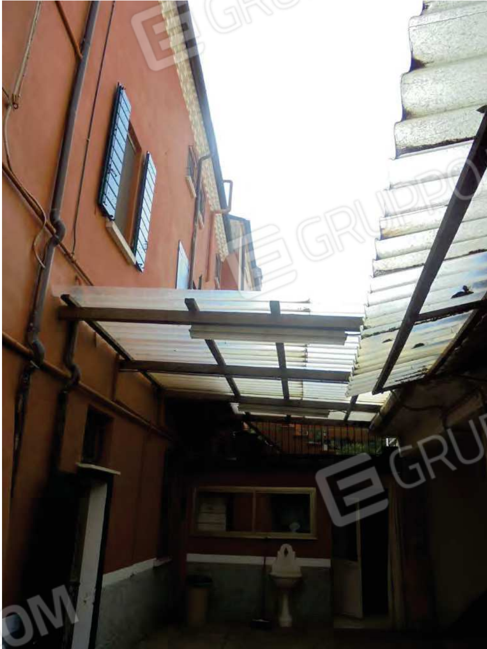
Foto 21. Vista tettoia comune.
