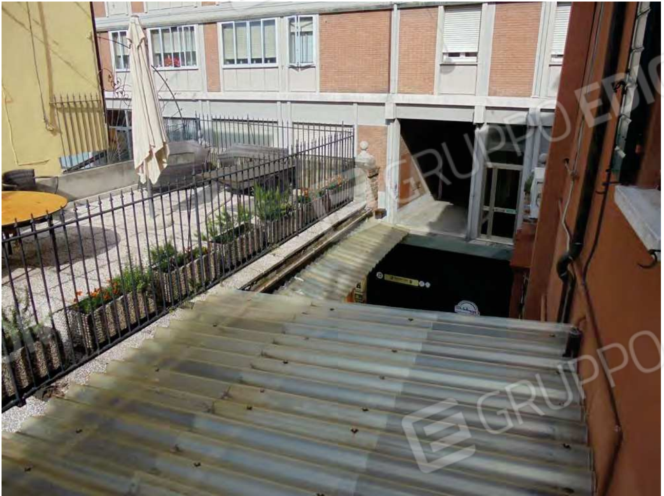
Foto 27. Particolare terrazza comune.
