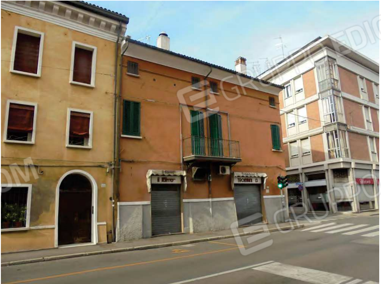
Foto 1. Prospetto sud – ovest . Vista da Corso Porta Po.
