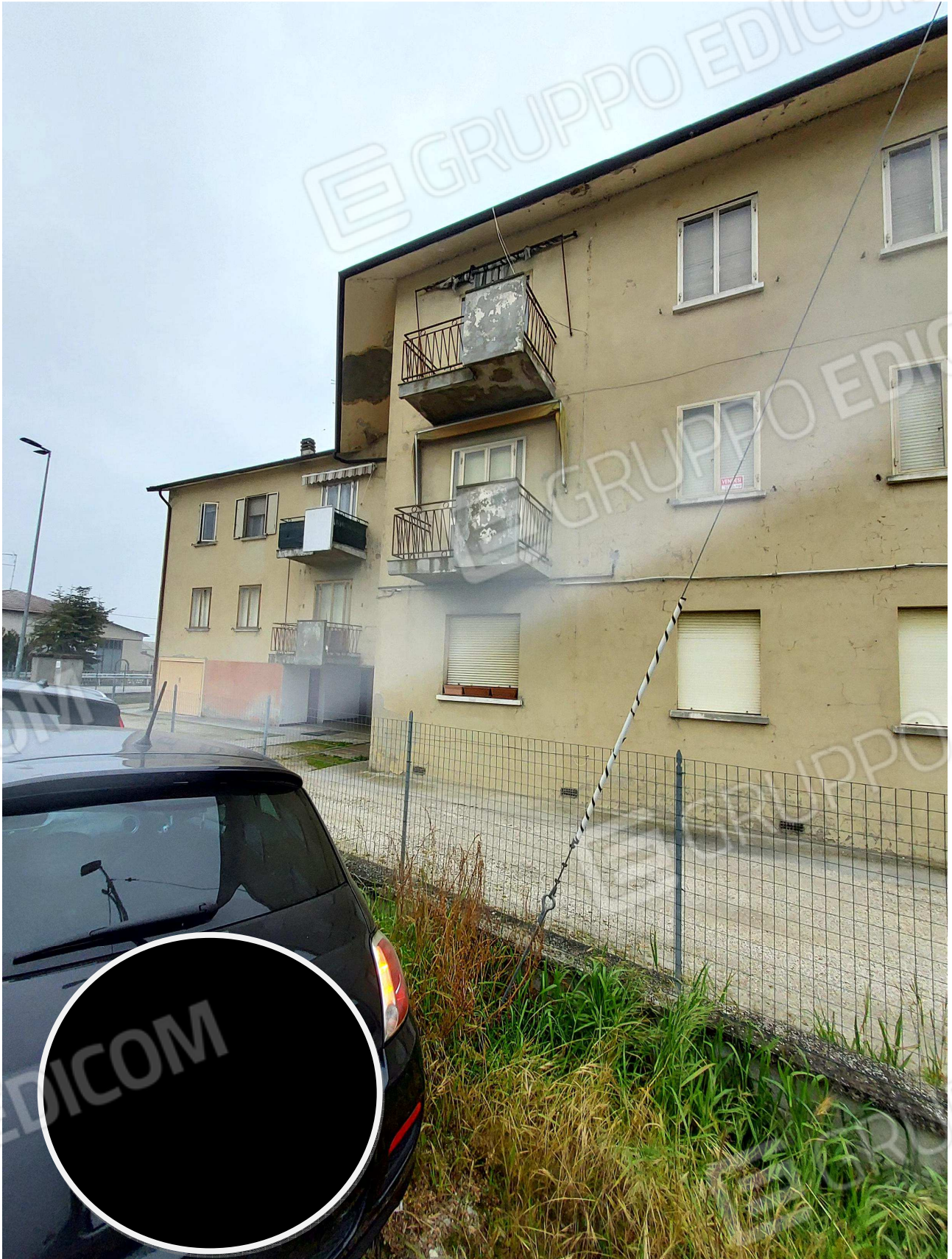
FACCIATA PRINCIPALE (Via Bengasi)
