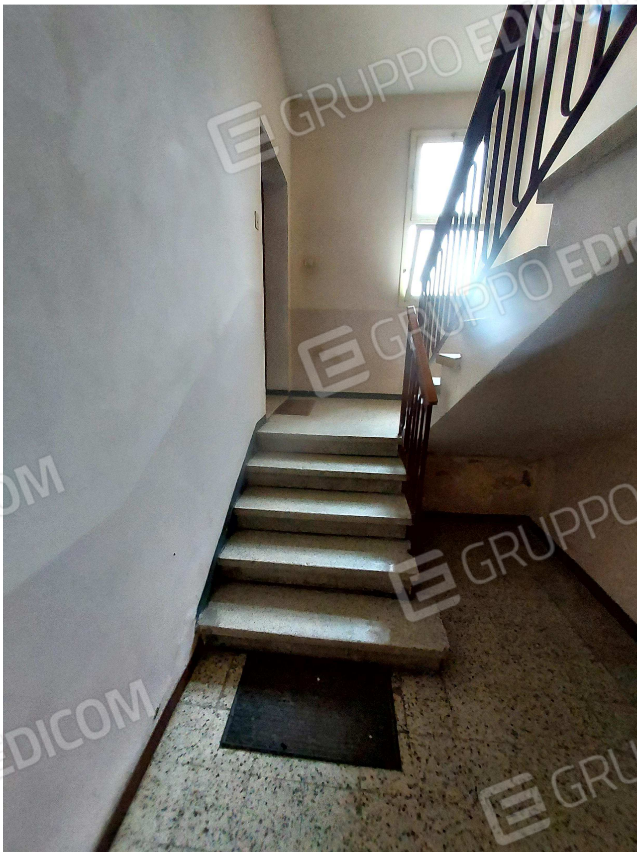
VANO SCALA COMUNE
