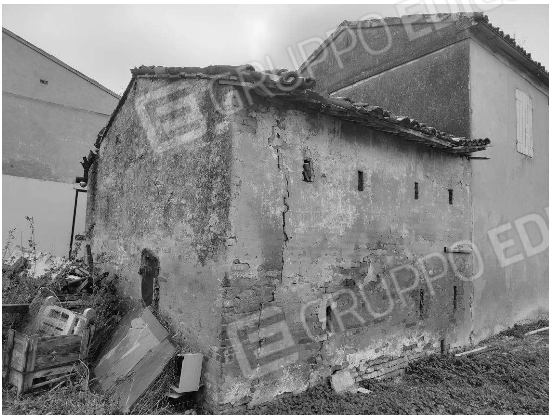
FOTO 3 – corpo di fabbrica destinato a legnaia e pollaio
