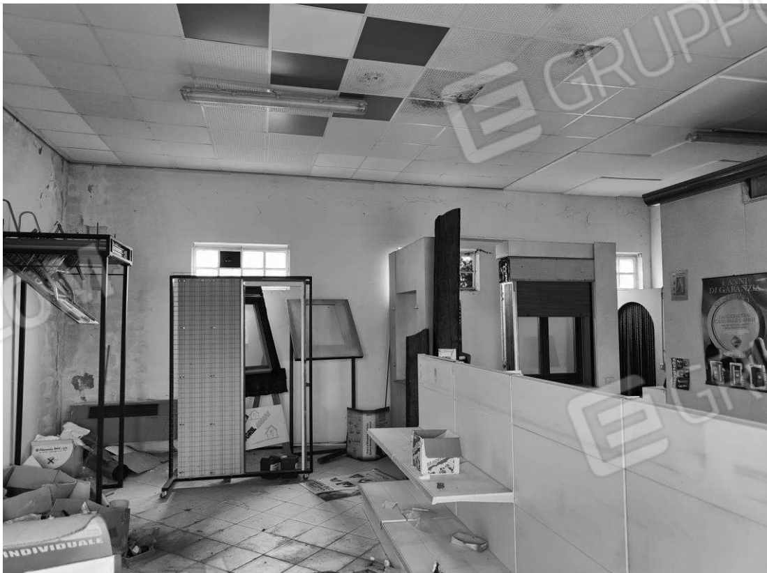
FOTO 12 – fabbricato “A” zona esposizione
