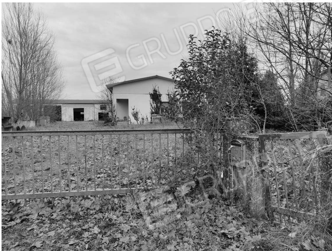
FOTO 1 – ingresso dalla pubblica strada
