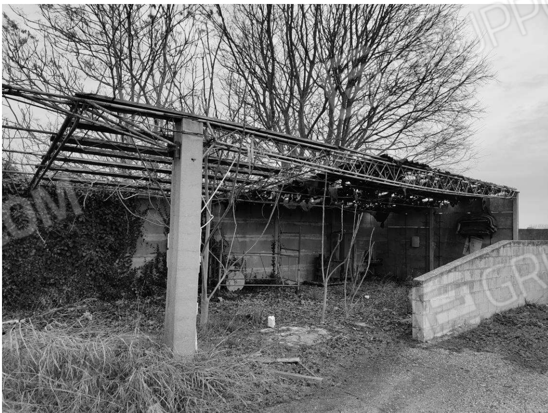
FOTO 6 – tettoia lavorazione ferro
