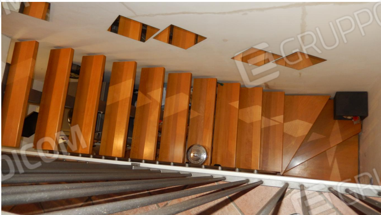
PARTICOLARE SCALA AUTOPORTANTE IN LEGNO E ACCIAIO
