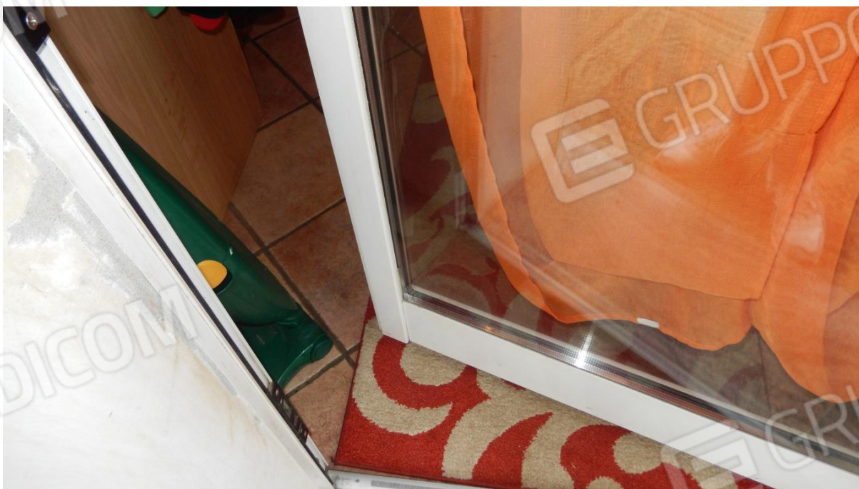
PARTICOLARE INFISSI RECENTI (MODERNI)
