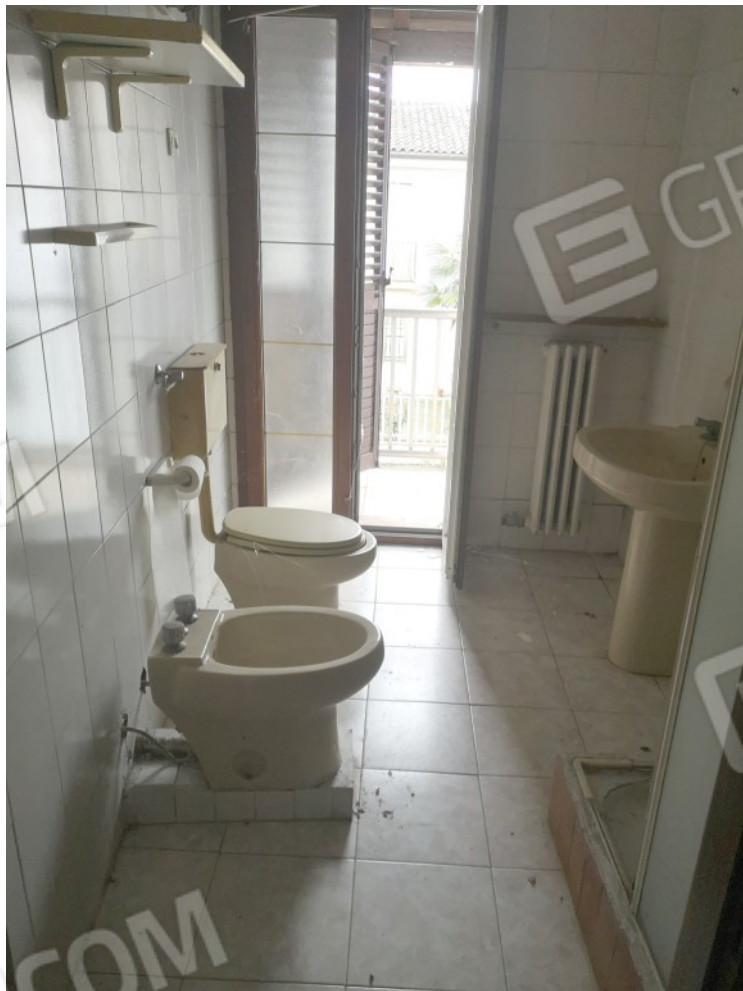
BAGNO PIANO PRIMO
