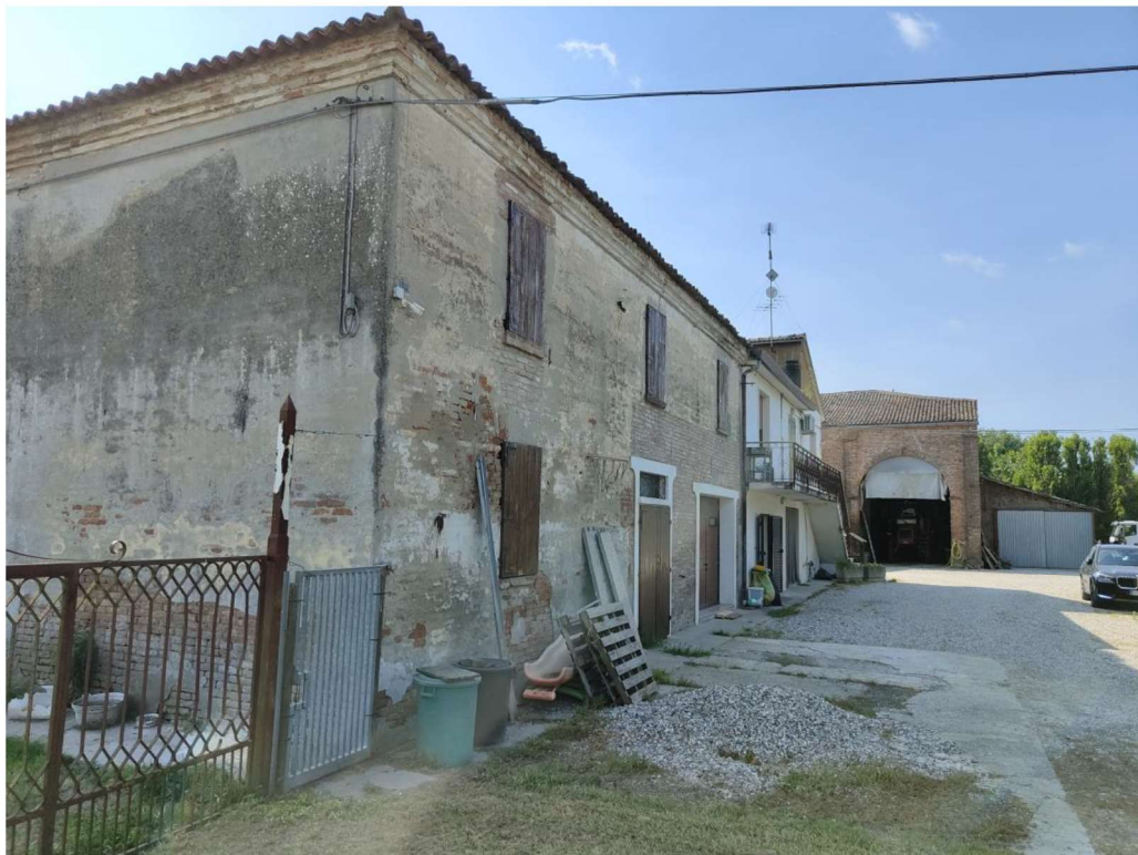
FOTO 4 – Lotto 1 – Abitazione, garage e magazzino
