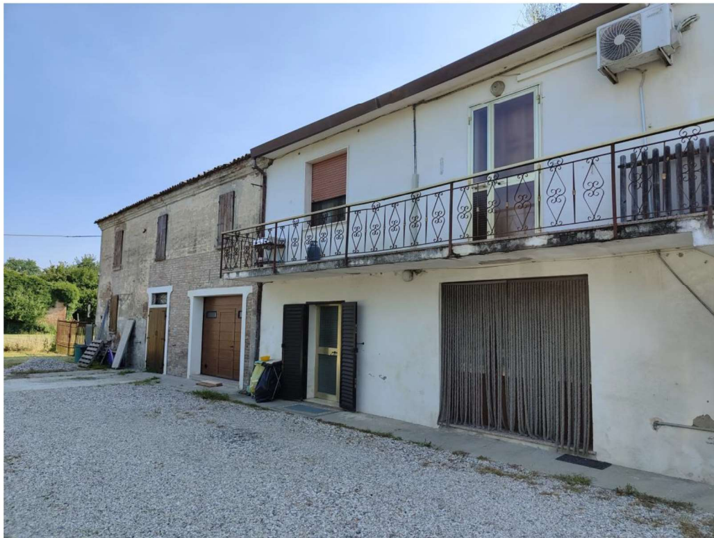
FOTO 3 – Lotto 1 – Abitazione, garage e magazzino
