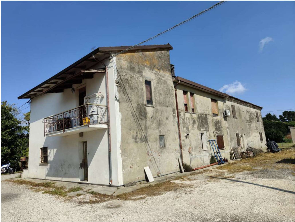
FOTO 5 – Lotto 1 – Abitazione, garage e magazzino
