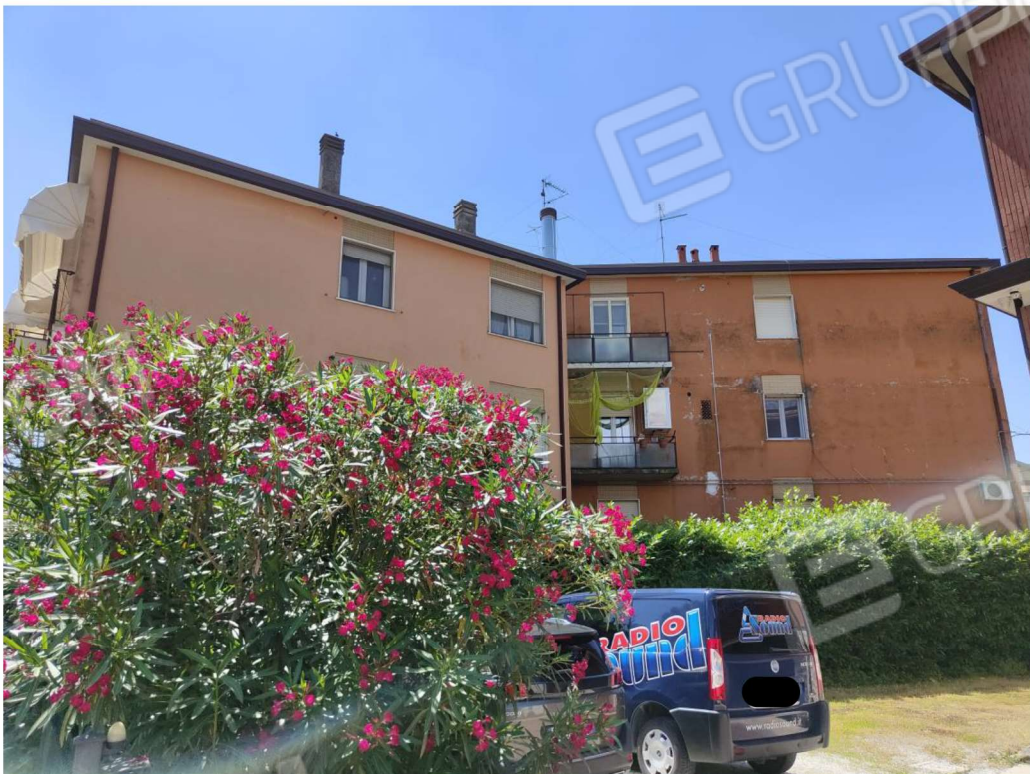
FOTO 2 – Vista fronte laterale
