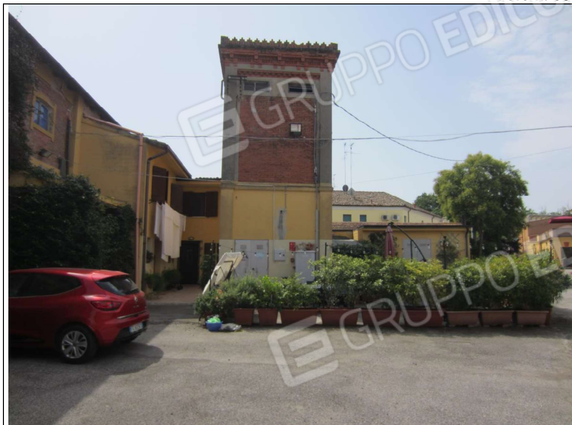
VEDUTA PROSPETTICA - AREA URBANA MAPP. 237 SUB 1 (E SOVRASTANTE CABINA ELETTRICA)
