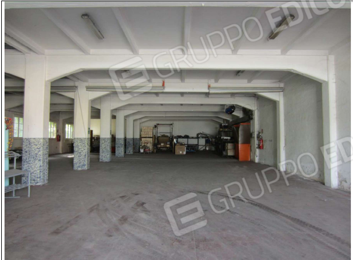
INTERNO MAGAZZINO-FRIGO-LAVORAZIONE MAPP. 239 SUB 5
