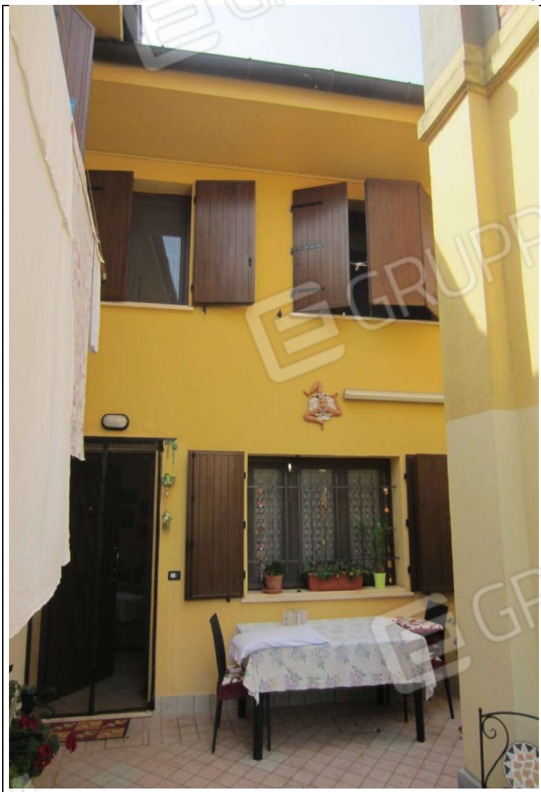
ESTERNO UNITA' ABITATIVA MAPP. 239 SUB 6 - 35 SUB 28
