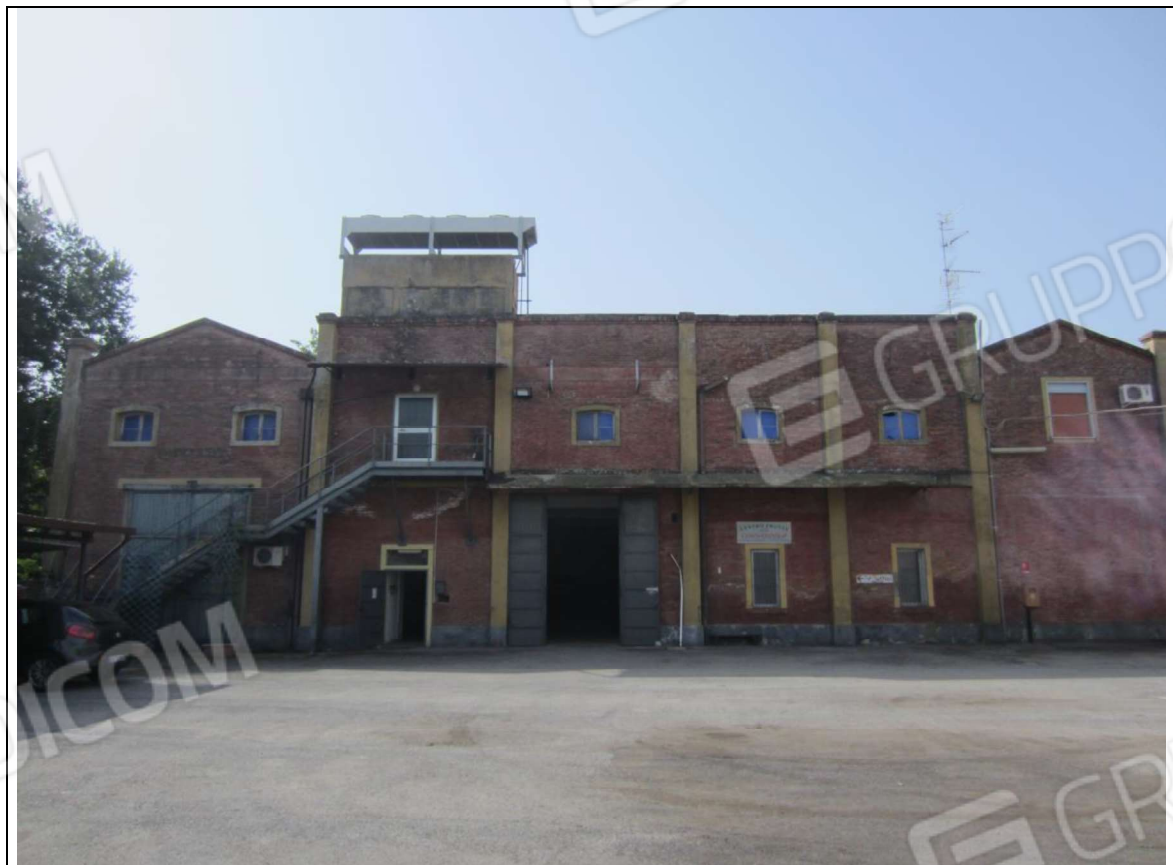
PROSPETTO GENERALE FABBRICATO CON LE UNITA' MAPPALI 239 SUB 5 E 239 SUB 7
