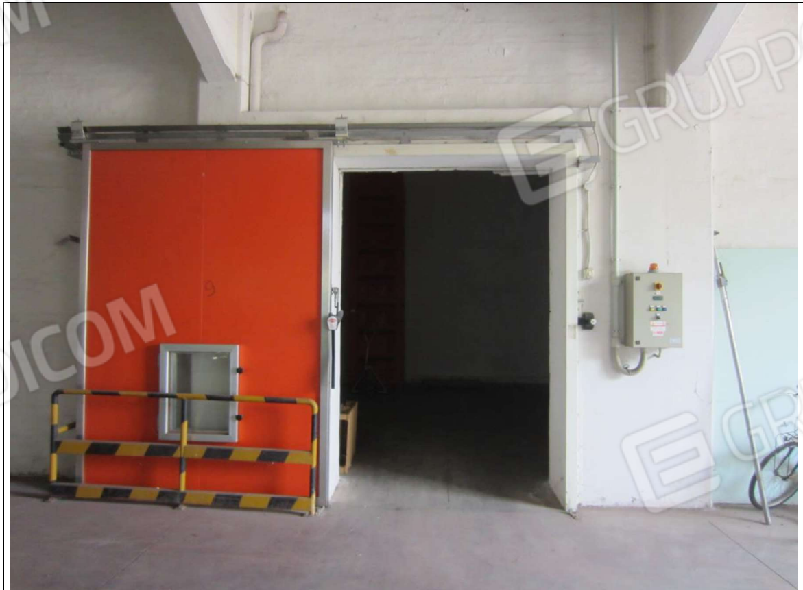
INTERNO MAGAZZINO-FRIGO-LAVORAZIONE MAPP. 239 SUB 5
