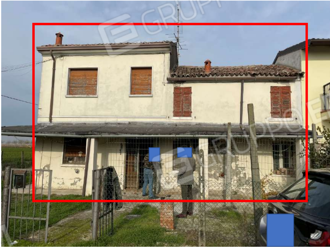
PROSPETTO FRONTE ABITAZIONE
