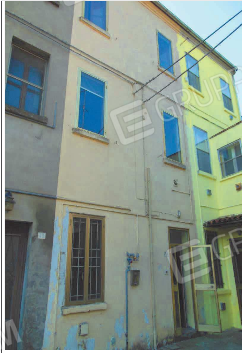
PROSPETTO FRONTALE IMMOBILE
