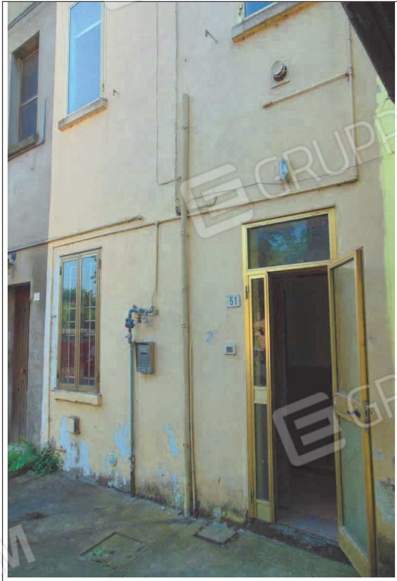
PROSPETTO FRONTALE IMMOBILE
