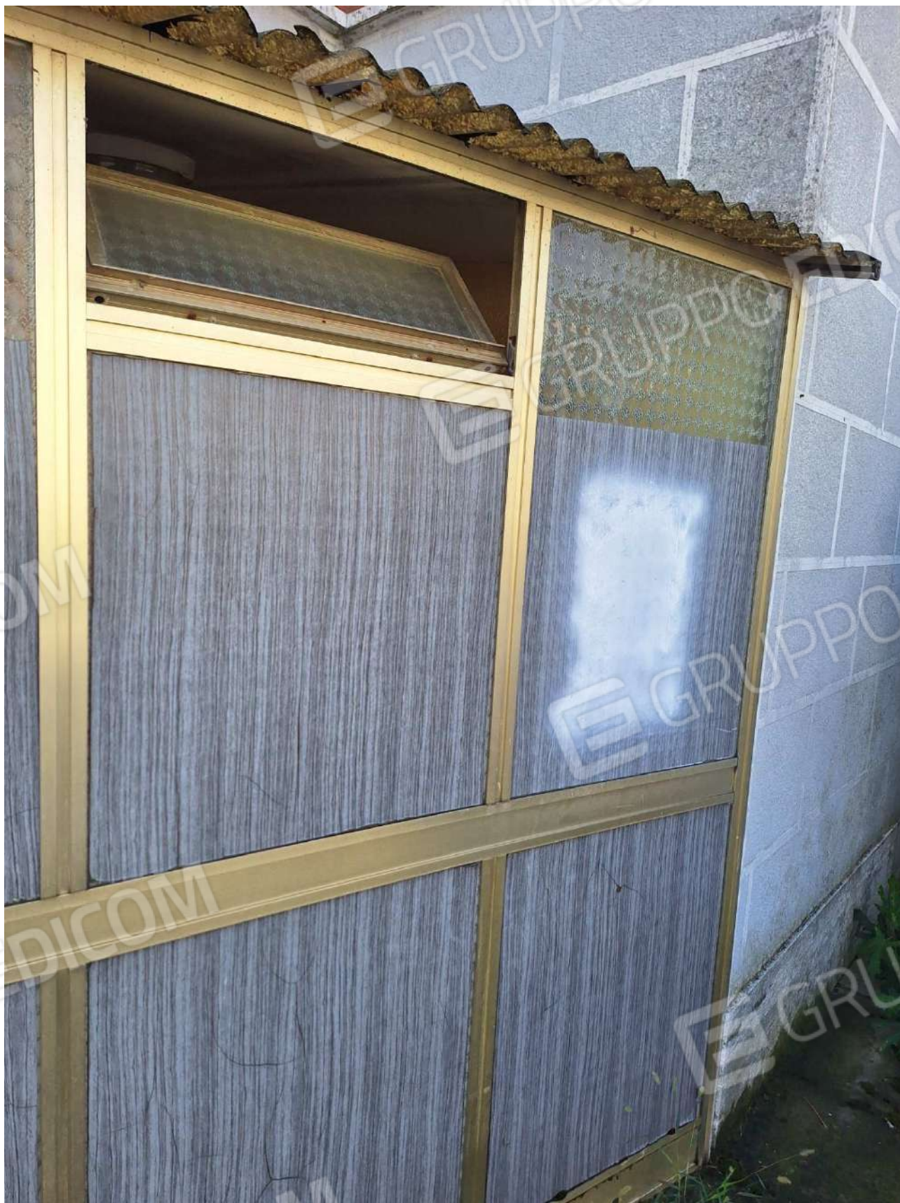
W.c. vista esterna
