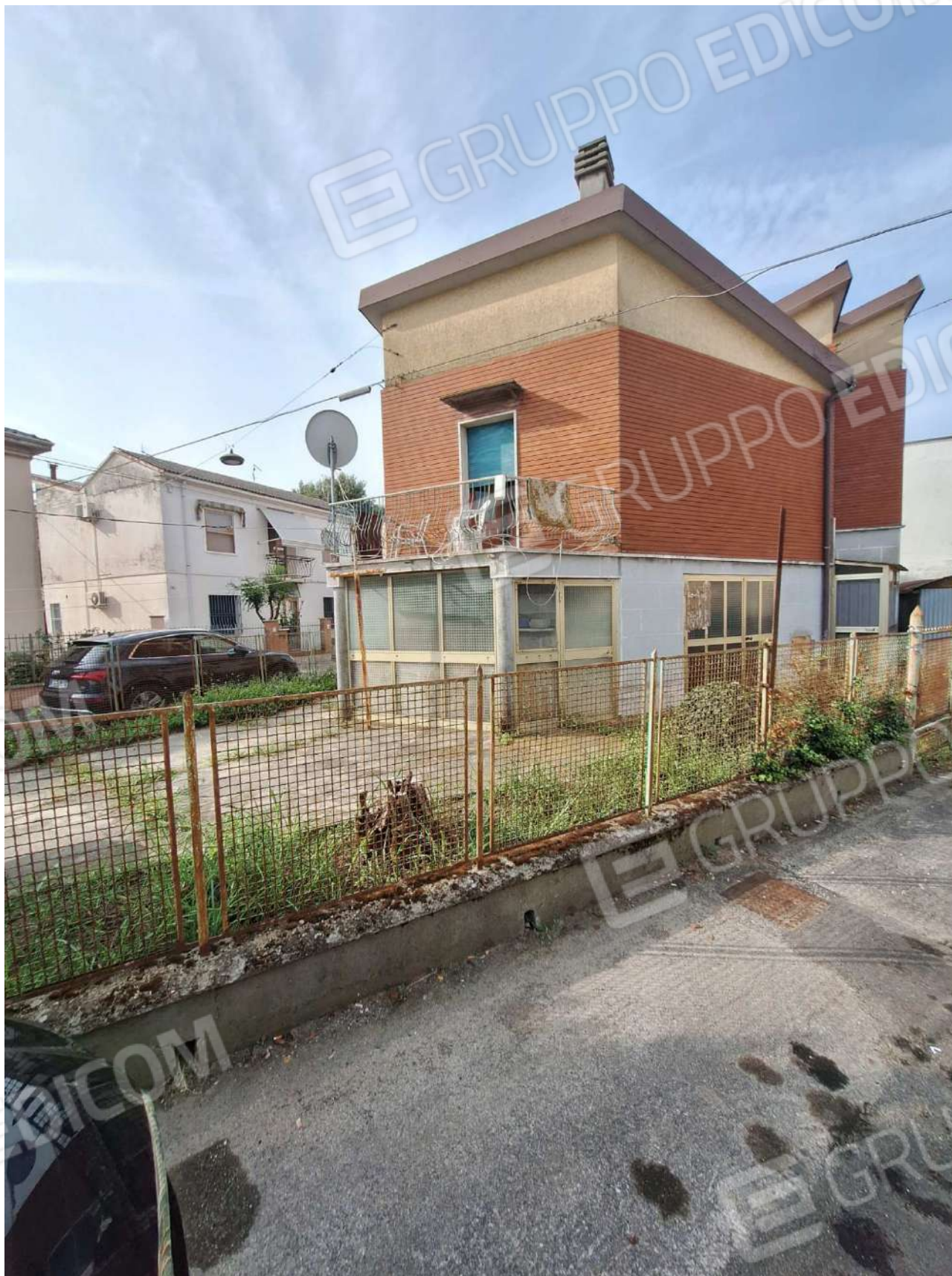
Facciata su Via 1° Maggio
