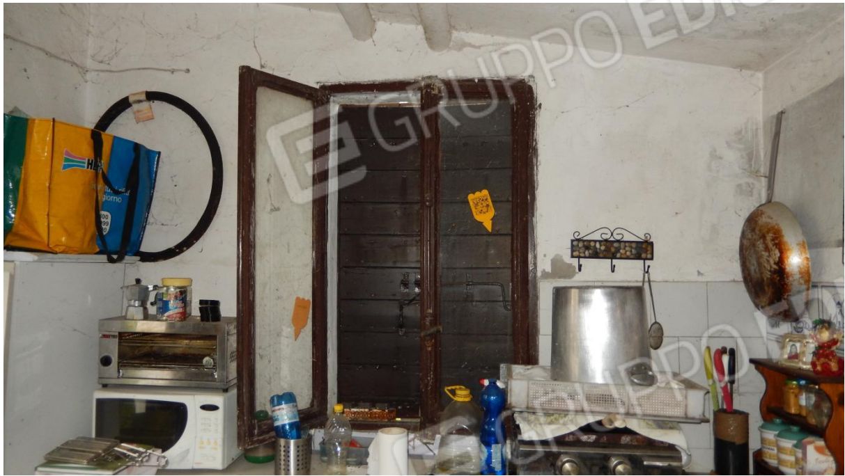
PARTICOLARE INTERNO LOCALE EX LAVANDERIA (MOLTO VETUSTO)
