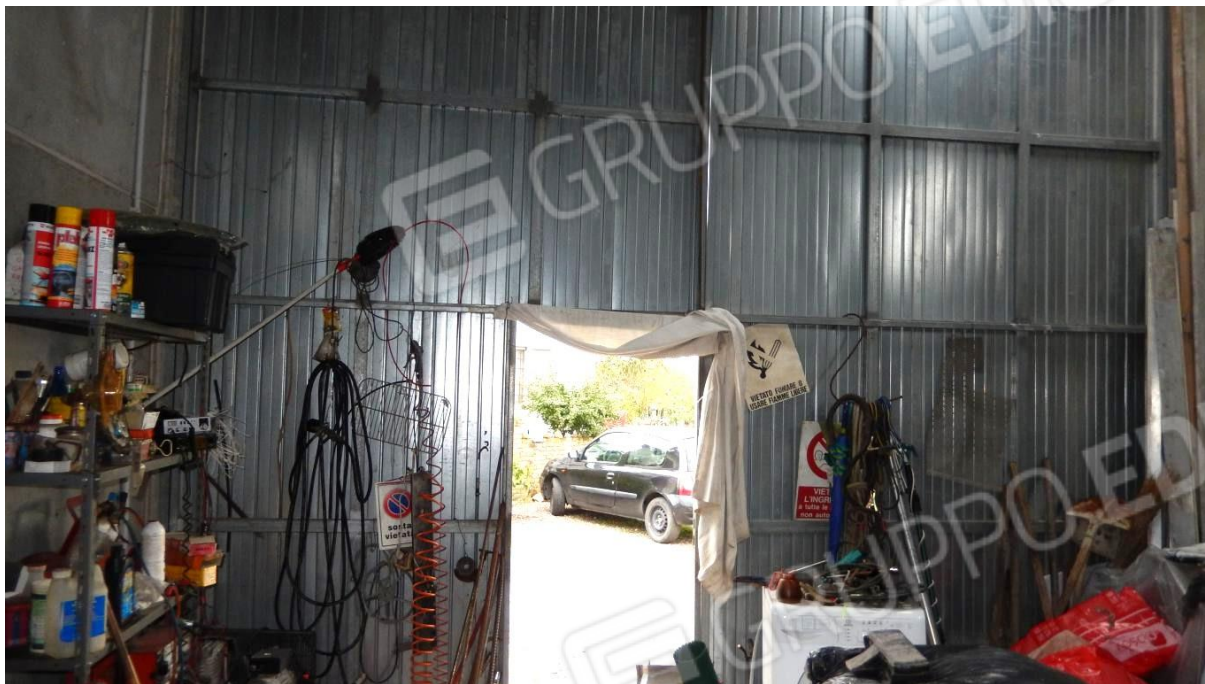
VISTA INTERNA VERSO ACCESSO PRINCIPALE A TUTTA LUCE
