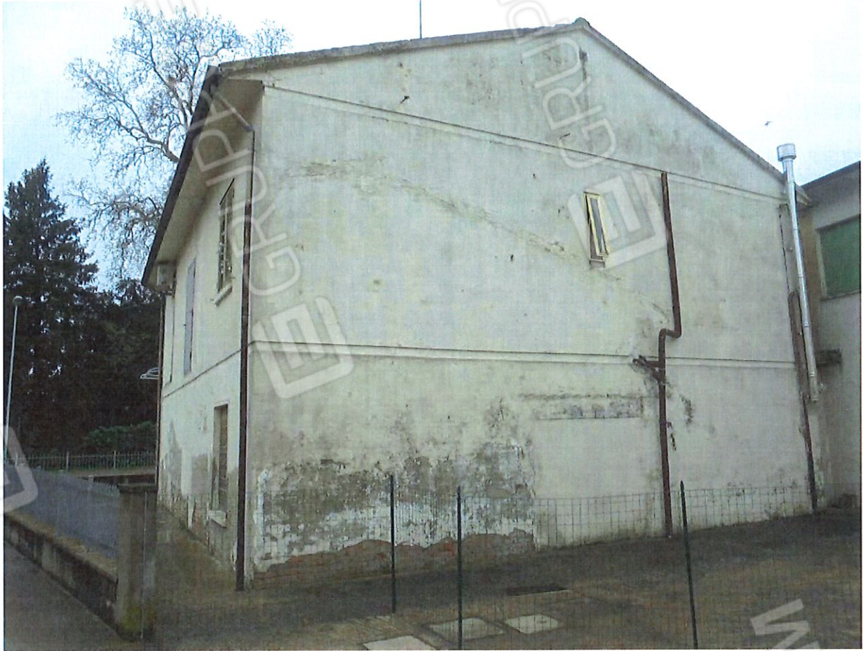
Foto 3. Prospetto Nord – Est. Vista da passo carrabile.
