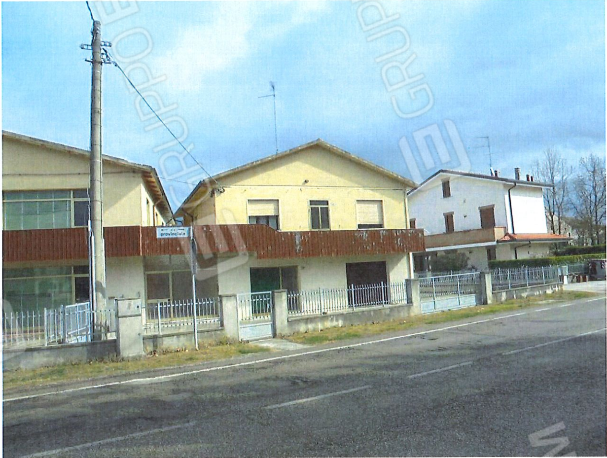
Foto 2. Prospetto Sud – Ovest. Vista da Via Provinciale.
