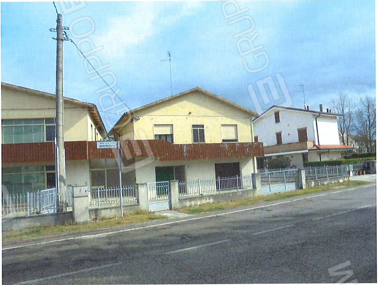
Foto 2. Prospetto Sud – Ovest. Vista da Via Provinciale.
