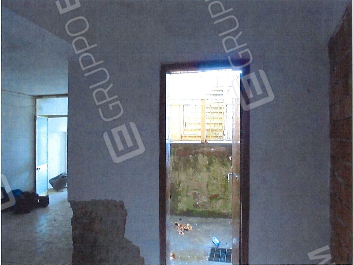
Foto 14. Magazzino. Particolare degli interni.
