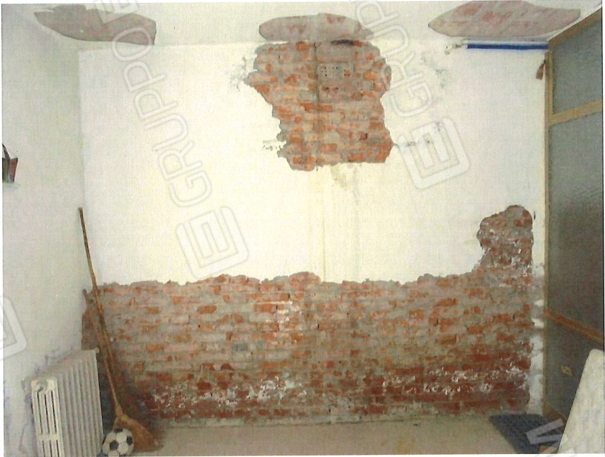
Foto 7. Magazzino. Particolare degli interni.
