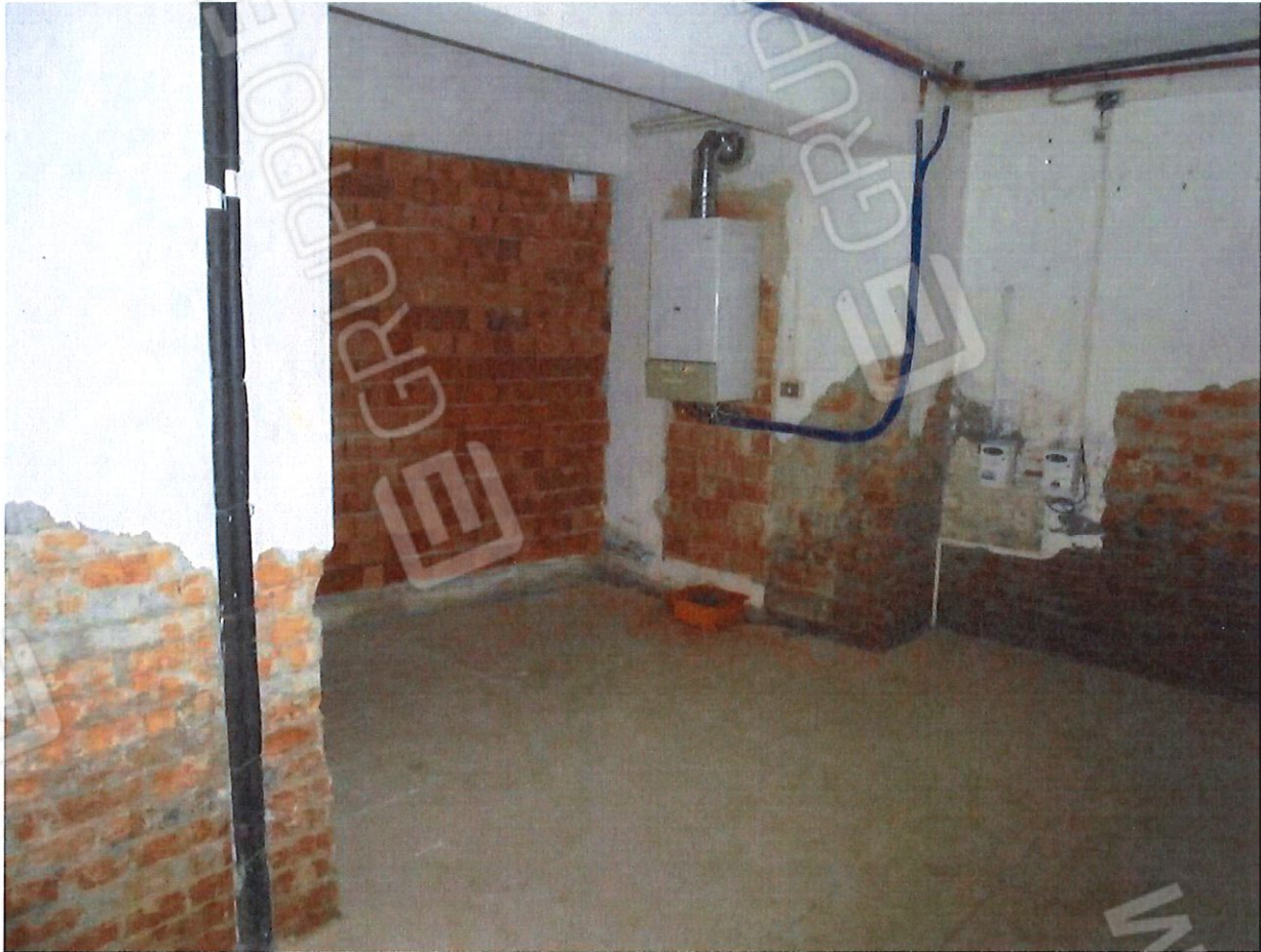
Foto 13. Magazzino. Particolare degli interni.
