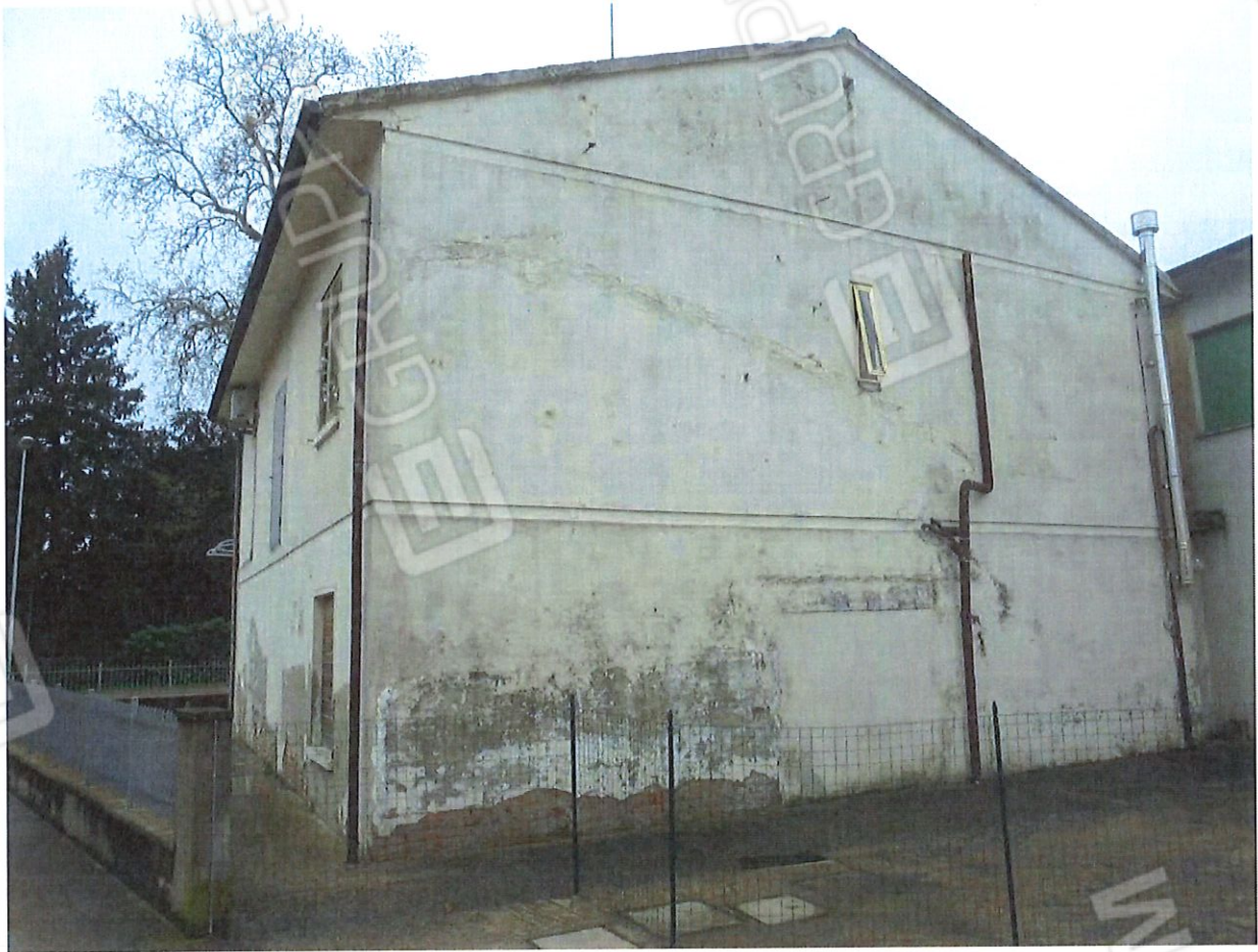
Foto 3. Prospetto Nord – Est. Vista da passo carrabile.
