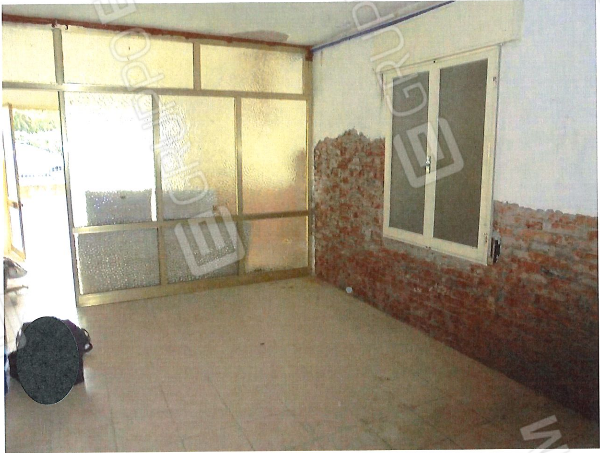
Foto 8. Magazzino. Particolare degli interni.
