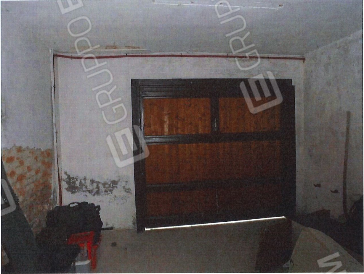
Foto 11. Magazzino. Particolare degli interni.
