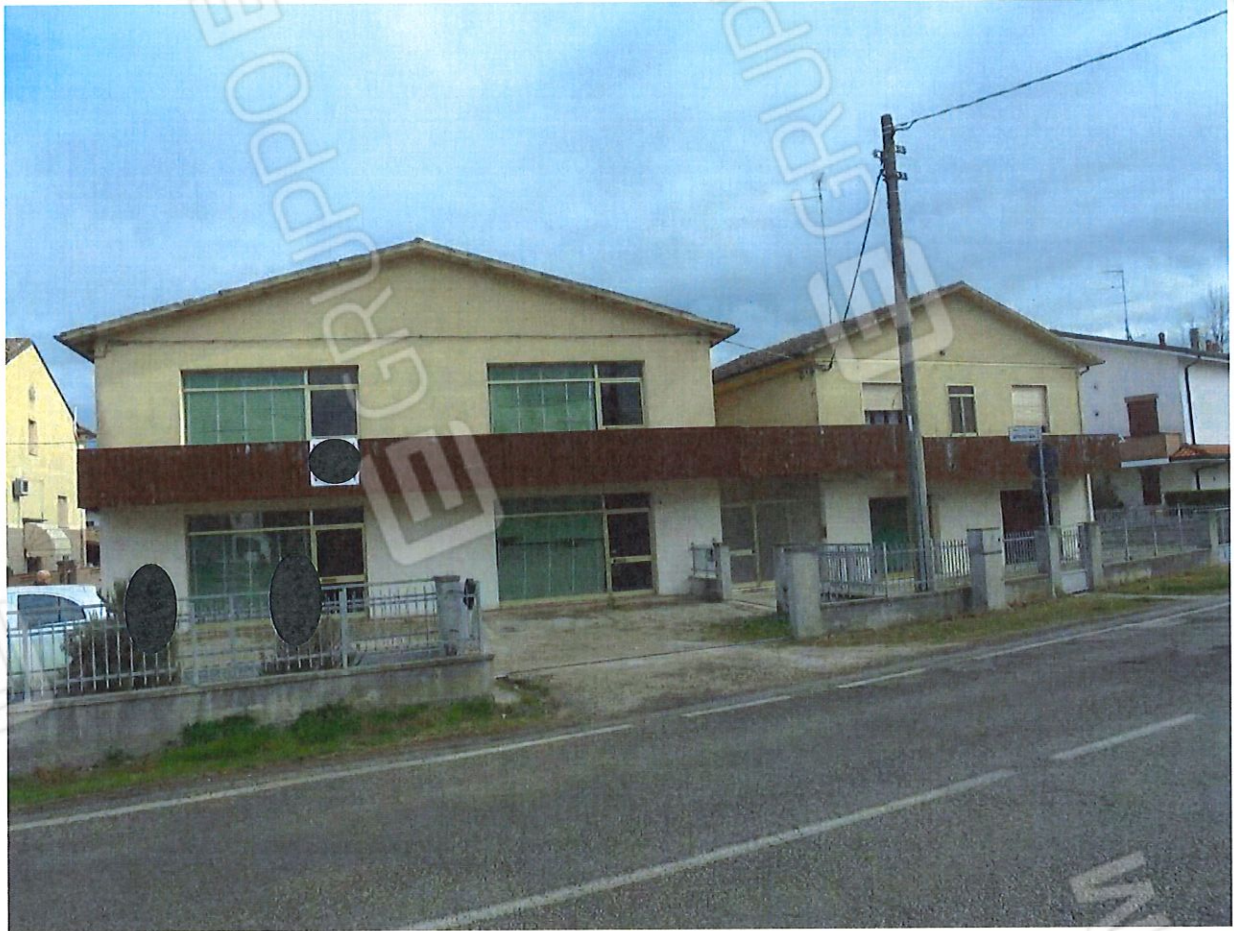
Foto 1. Prospetto Sud – Ovest. Vista da Via Provinciale.
