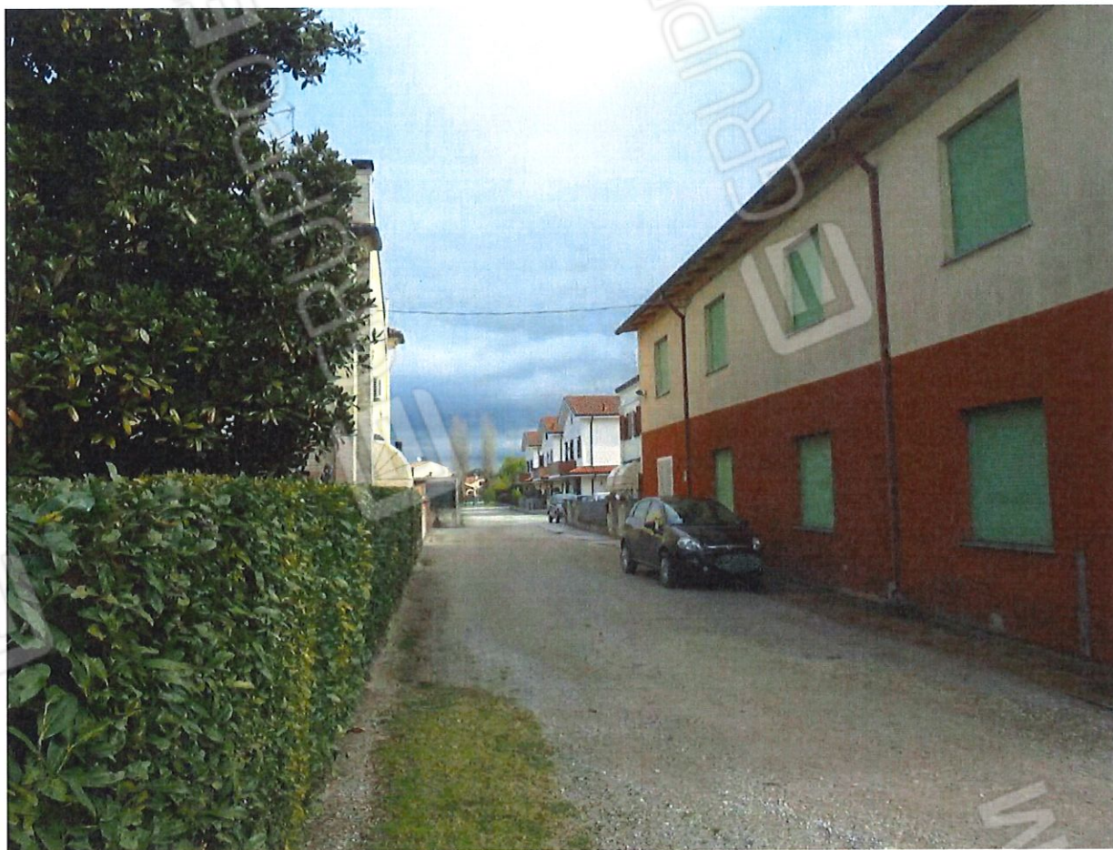
Foto 4. Prospetto Nord – Ovest. Vista da Via Provinciale.
