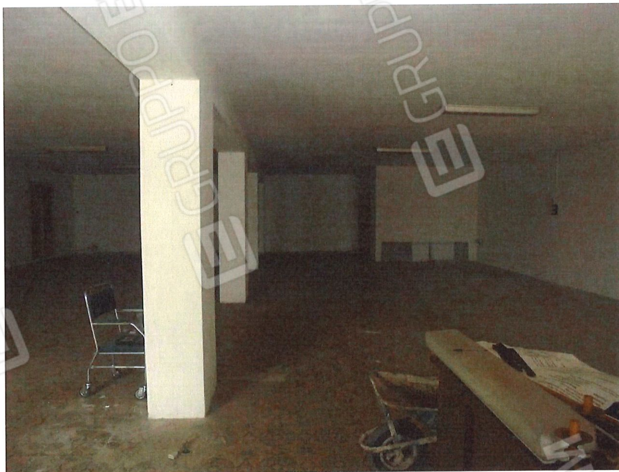
Foto 14. Magazzino – Piano terra. Particolare degli interni.
