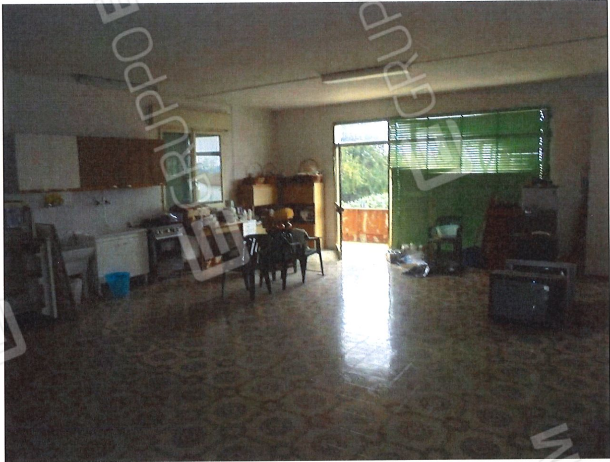
Foto 16. Magazzino – Piano primo. Particolare degli interni.
