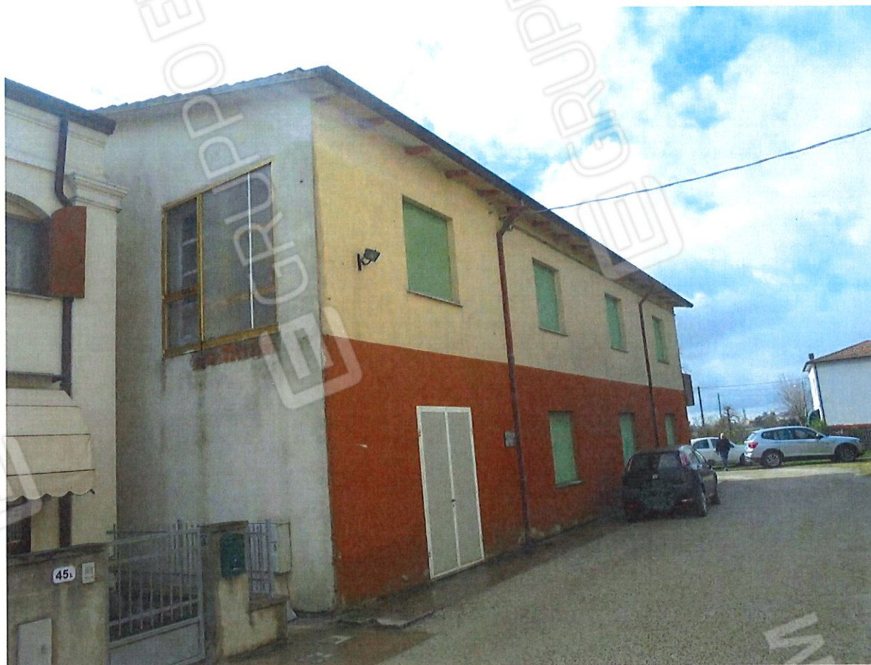
Foto 5. Prospetto Nord – Ovest. Vista da passo carrabile..
