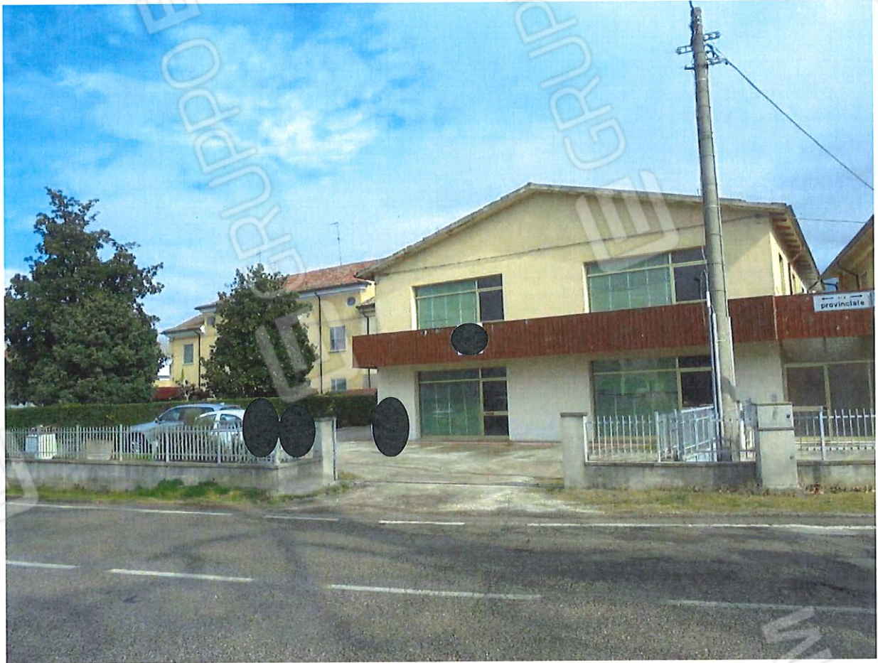
Foto 2. Prospetto Sud – Ovest. Vista da Via Provinciale.
