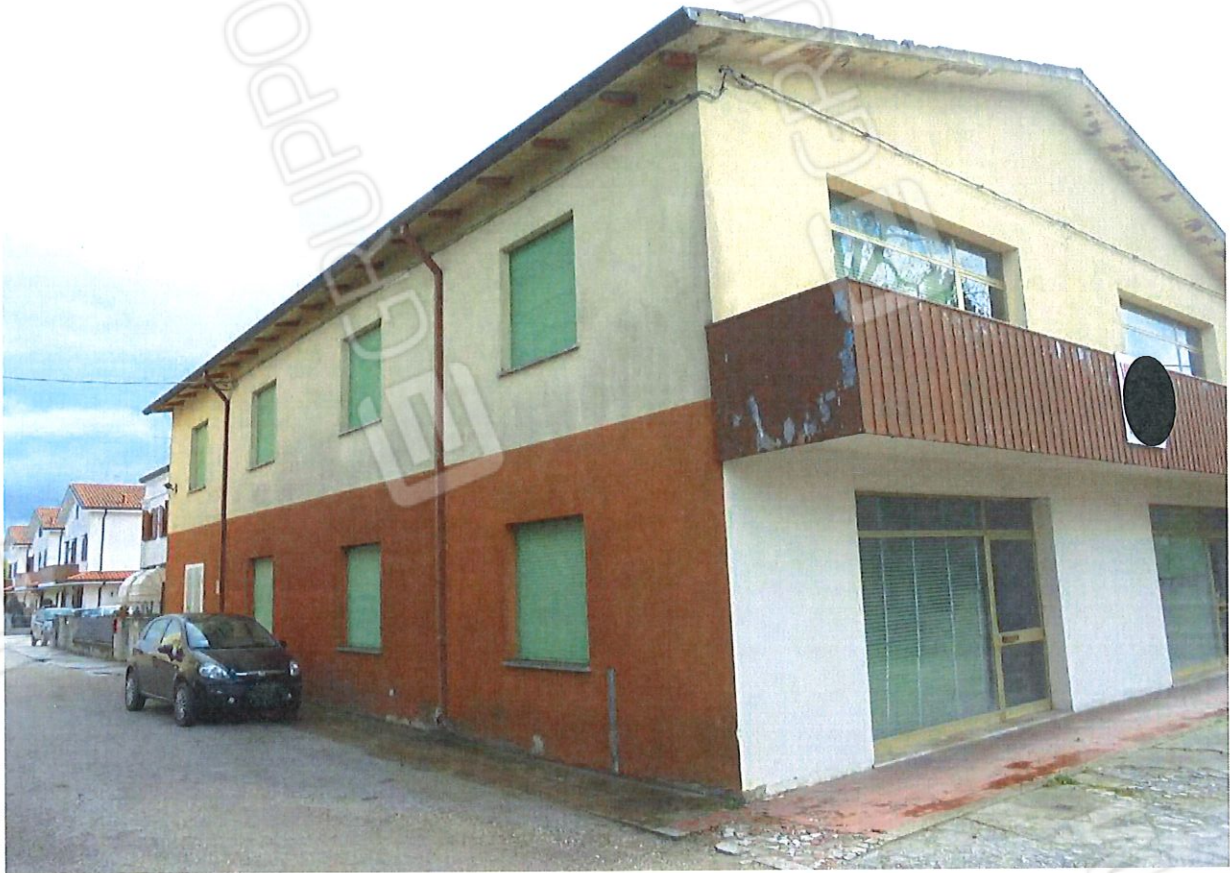
Foto 3. Prospetto Nord – Ovest. Vista da Via Provinciale.
