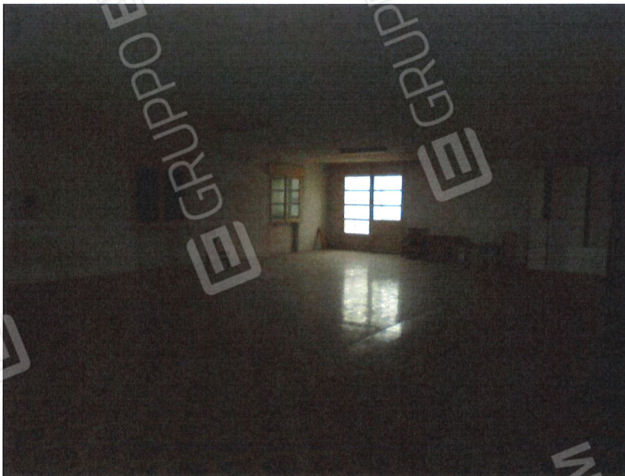
Foto 20. Magazzino – Piano primo. Particolare degli interni.
