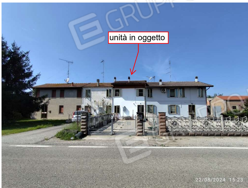
0.1 – vista da via Postale
