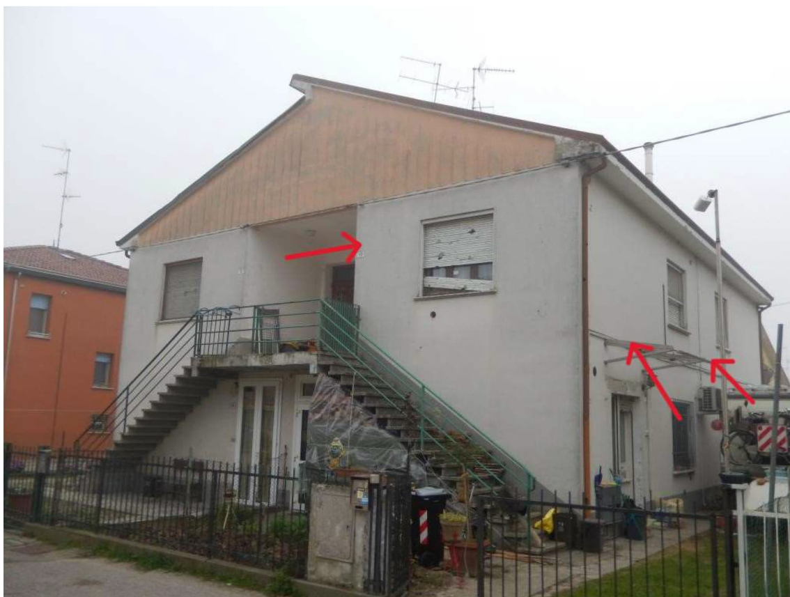
PROSPETTO D'INSIEME (TAPPARELLE DISTRUTTE DA GRANDINATA)
