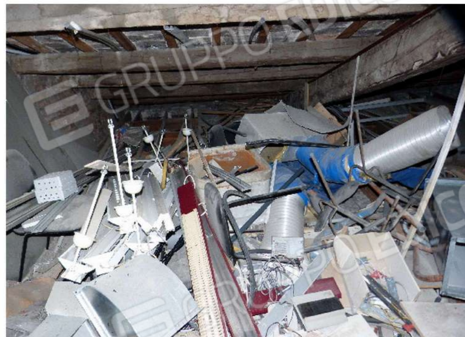
sottotetto accessibile dal soppalco piano secondo
