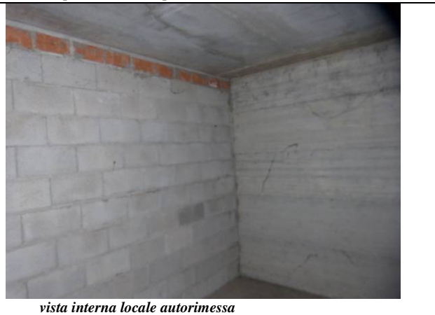
vista interna locale autorimessa
