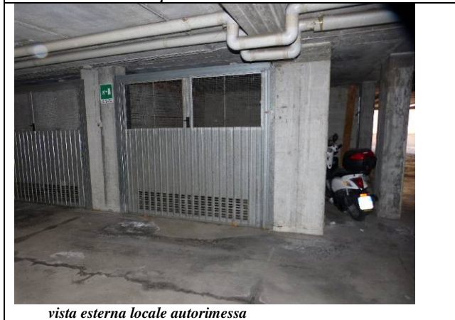
vista esterna locale autorimessa
