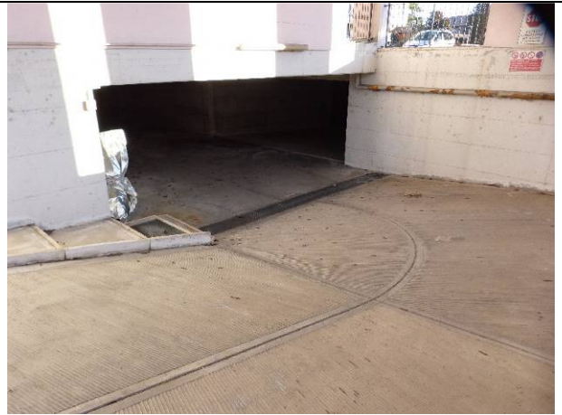
rampa di accesso al piano seminterrato
