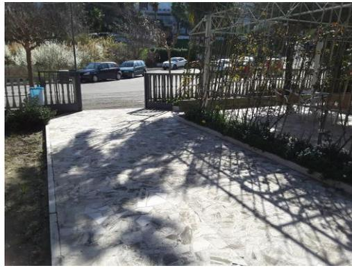
Sui restanti tre lati è in parte delimitata da un basamento in cemento con sovrastante rete metallica plastificata sorretta da paletti in ferro, in parte con pannelli decorati in cemento prefabbricato ed in parte in rete metallica plastificata sorretta da paletti in ferro.
