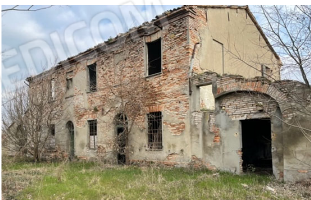
la casa - lato Nord
