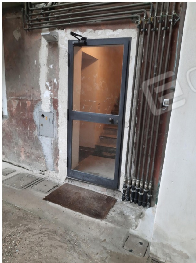
7- VISTA ACCESSO A SCALE COMUNI DAL CORTILE (per l'interno 4)
