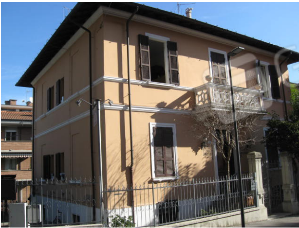
Scorci prospetti esterni
