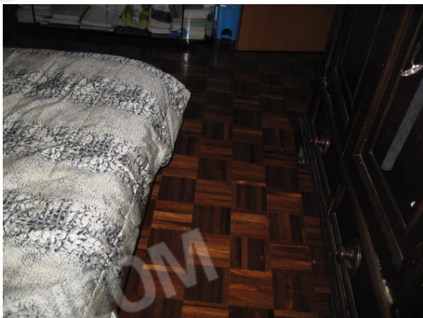
Particolare pavimento camere e bagno
