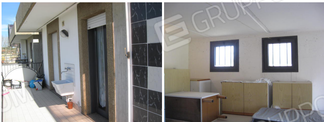
Balcone posteriore e garage
