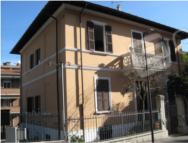
Scorci prospetti esterni
