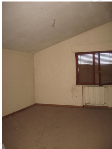
Balcone e vano piano secondo
