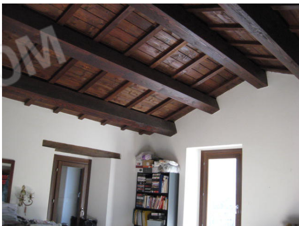
Camera e bagno piano primo
