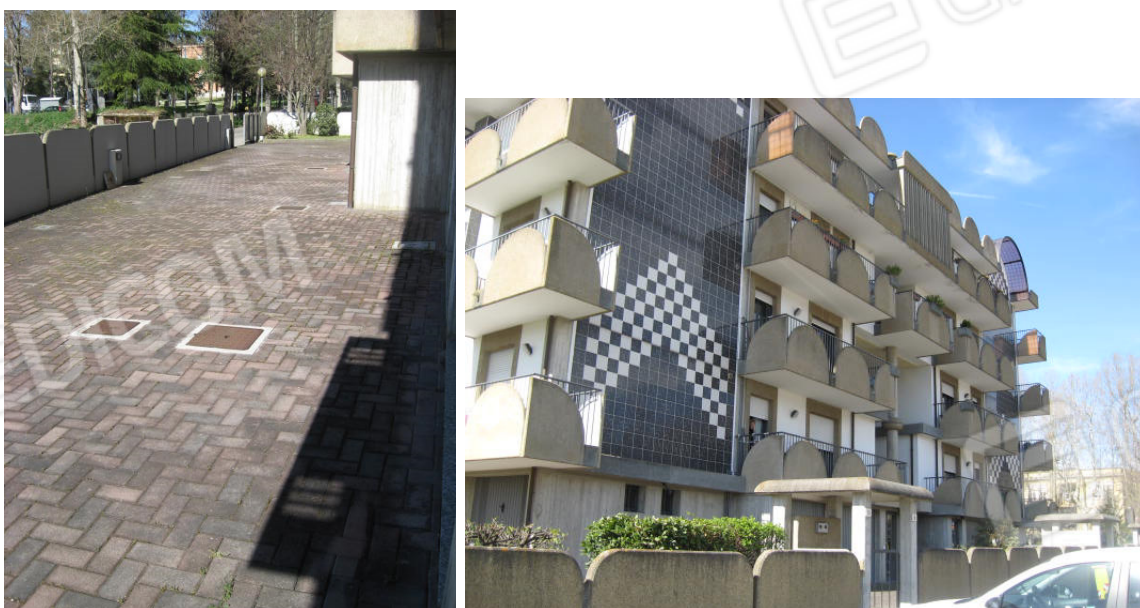
Area esterna zona garage e scorcio fronte strada
