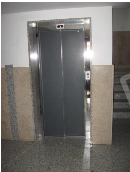
Vista ascensore e ingresso comune
