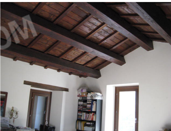
Camera e bagno piano primo
