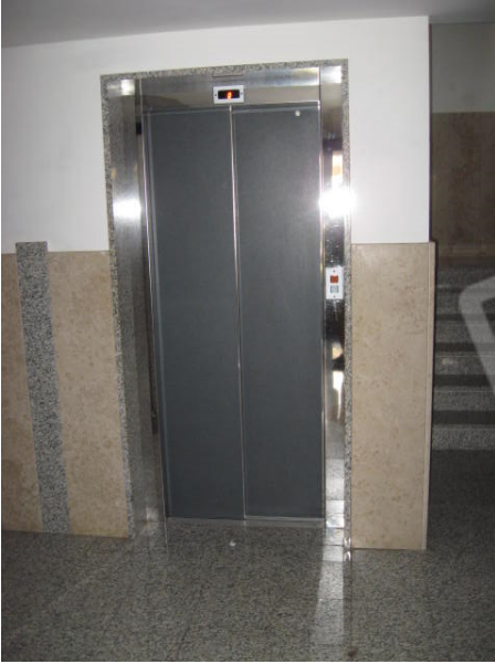
Vista ascensore e ingresso comune
