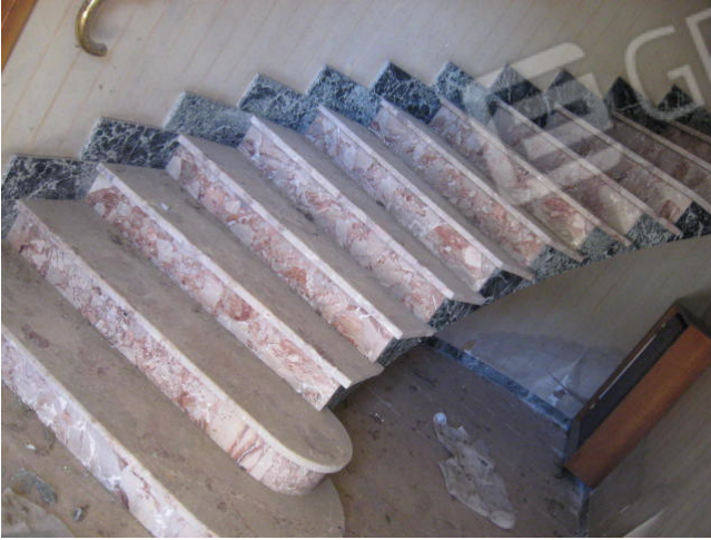
Scala interna e ingresso ascensore
