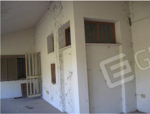
Terrazzo coperto piano secondo
