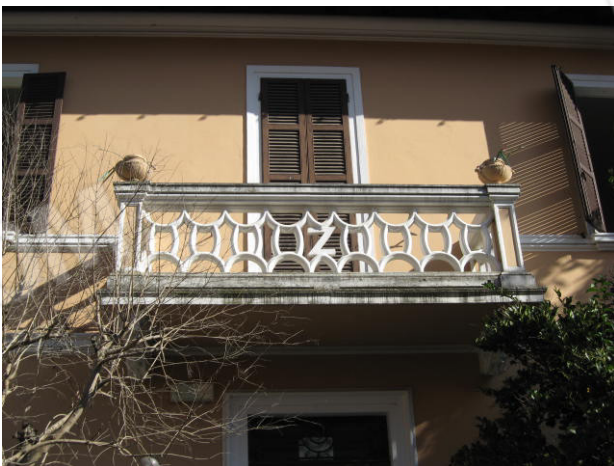
Balcone fronte strada e cancello di ingresso
