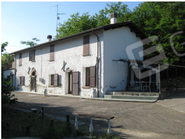
Scorci dei prospetti esterni
