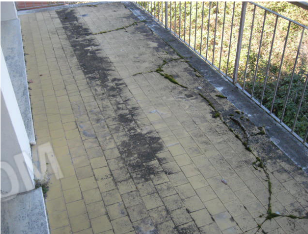
Balcone e scala esterna prospetto posteriore
