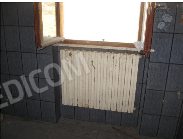
Particolare bagno piano secondo e vano piano primo
