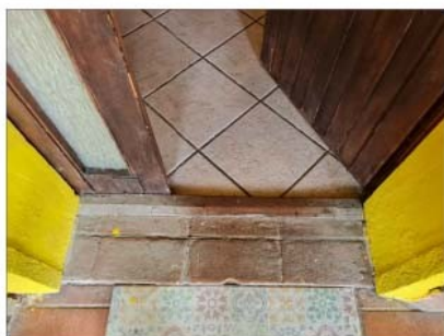
FOTO 52 - DETTAGLIO PAVIMENTO INGRESSO
