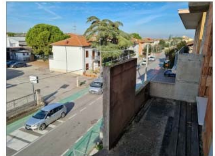
FOTO 45 - PIANO SECONDO BALCONE
