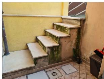
FOTO 12 - SCALETTA DI ACCESSO AL PIANO SEMINTERRATO (CANTINE)
