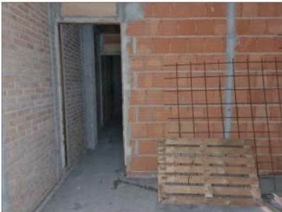
FOTO 16 - PIANO TERRA DISIMPEGNO E VANI
