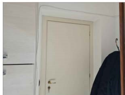
FOTO 21 - PORTA D'ACCESSO AL PIANO SEMINTERRATO
