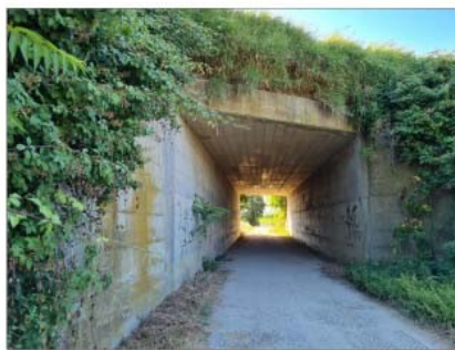
FOTO 05 - PONTE SUPERSTRADA E45
