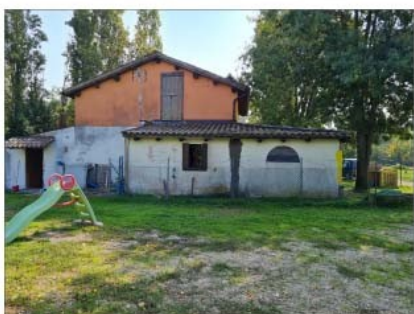
FOTO 16 - FRONTE LATERALE NORD-OVEST
