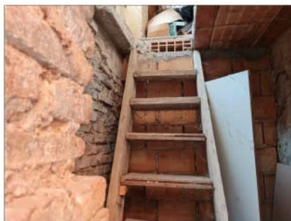
FOTO 26 - SCALA DI ACCESSO AL PIANO PRIMO (GREZZO)
