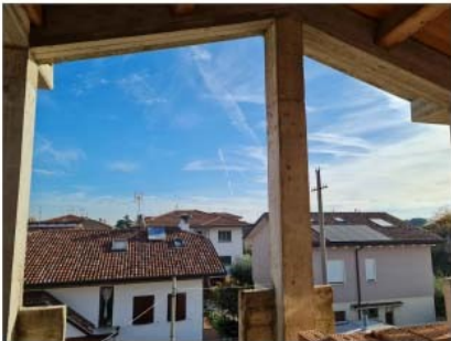
FOTO 43 - DETTAGLIO COPERTURA LOGGIA A PIANO SECONDO
