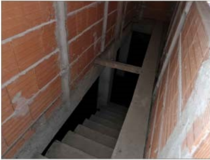
FOTO 37 - SCALA CONDOMINIALE PIANO INTERRATO
