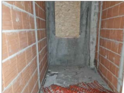
FOTO 17 - PIANO TERRA VANO CON APERTURA TAMPONATA
