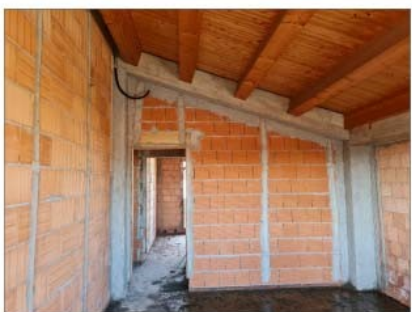
FOTO 31 - PIANO SECONDO MANSARDATO COPERTURA IN LEGNO
