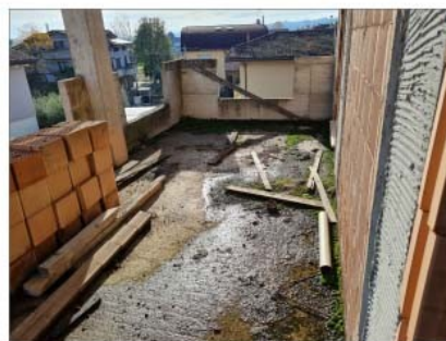
FOTO 42 - BALCONE SUL RETRO A PIANO SECONDO
