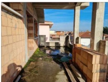
FOTO 40 - BALCONE SUL RETRO A PIANO SECONDO
