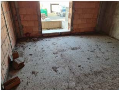
FOTO 19 - PIANO PRIMO PORTA FINESTRA BALCONE
