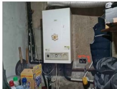
FOTO 57 - CALDAIA
