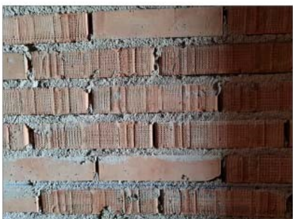
FOTO 35 - MURATURA VANO SCALA
