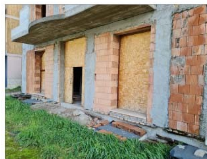
FOTO 06 - INGRESSO AL FABBRICATO
