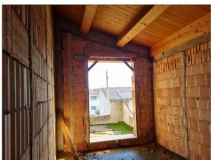
FOTO 32 - PIANO SECONDO PORTA FINESTRA BALCONE SUL RETRO
