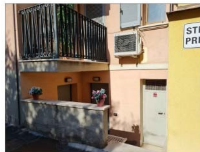
FOTO 06 - INGRESSO CANTINE SUL FRONTE RETRO DEL FABBRICATO
