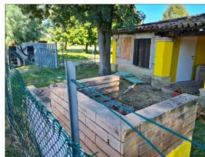
FOTO 12 - RECINZIONE E MANUFATTI
