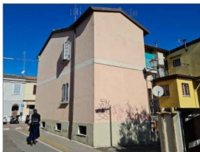
FOTO 05 - VISTA DEL FRONTE RETRO E DEL FRONTE LATERALE
