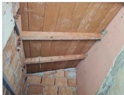
FOTO 27 - VISTA DELLA COPERTURA A PIANO PRIMO
