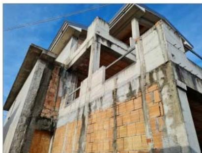
FOTO 08 - VISTA DEL RETRO
