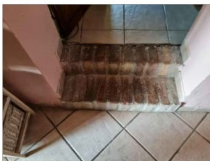
FOTO 62 - DETTAGLIO PAVIMENTO CAMERA PORTICO
