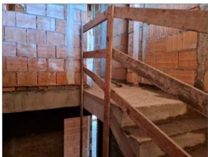
FOTO 28 - SCALA CONDOMINIALE A PIANO SECONDO
