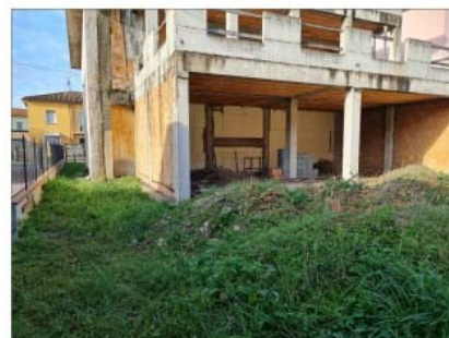
FOTO 12 - VISTA DEL PARCHEGGIO
