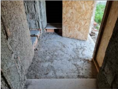
FOTO 25 - PORTICHETTO D'INGRESSO SOGLIE IN MARMO
