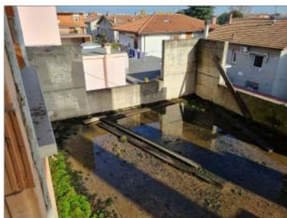
FOTO 41 - BALCONE SUL RETRO A PIANO SECONDO
