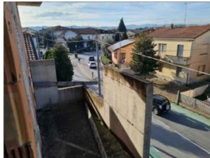
FOTO 44 - PIANO SECONDO BALCONE
