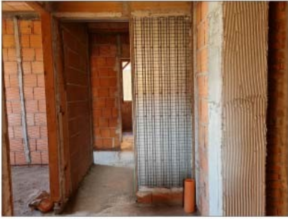
FOTO 22 - PIANO SECONDO CONTROTELAIO TIPO SCRIGNO
