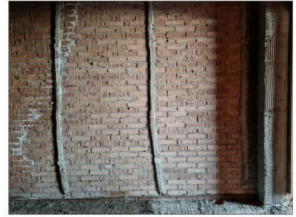
FOTO 24 - PARETI VANO SCALA
