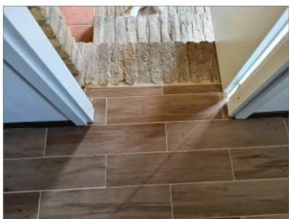
FOTO 61 - DETTAGLIO PAVIMENTO CAMERA PORTICO
