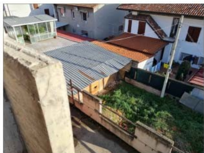
FOTO 46 - VISTA DEL CORTILE SUL RETRO
