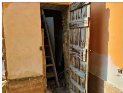
FOTO 25 - ACCESSO AL PIANO PRIMO
