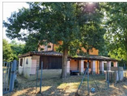
FOTO 09 - VISTA DA VIA CASETTI
