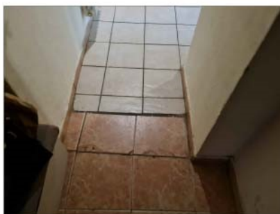
FOTO 53 - DETTAGLIO PAVIMENTI DISIMPEGNO
