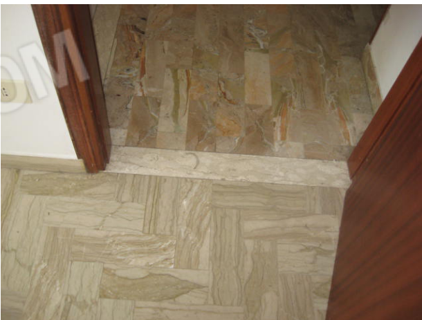
Particolare pavimentazioni e vista balcone
