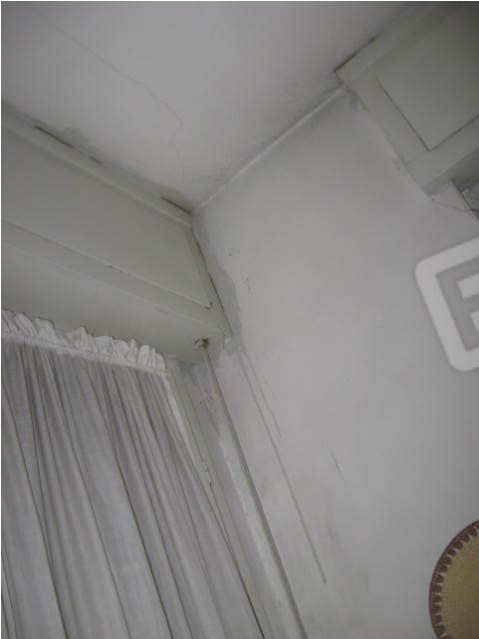
Particolare vani di abitazione
