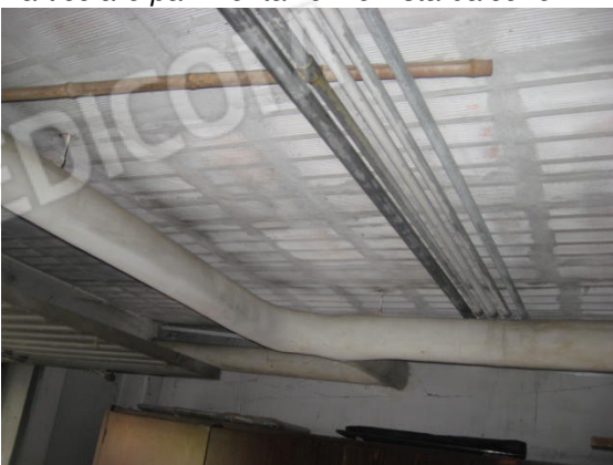
Particolare garage: soffitto e pavimento
