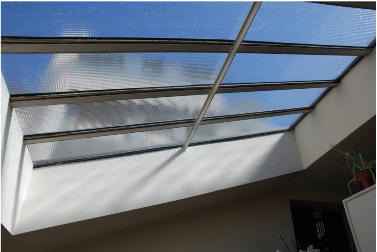
Fot.5. Vista del lucernaio condominiale al quarto piano.
