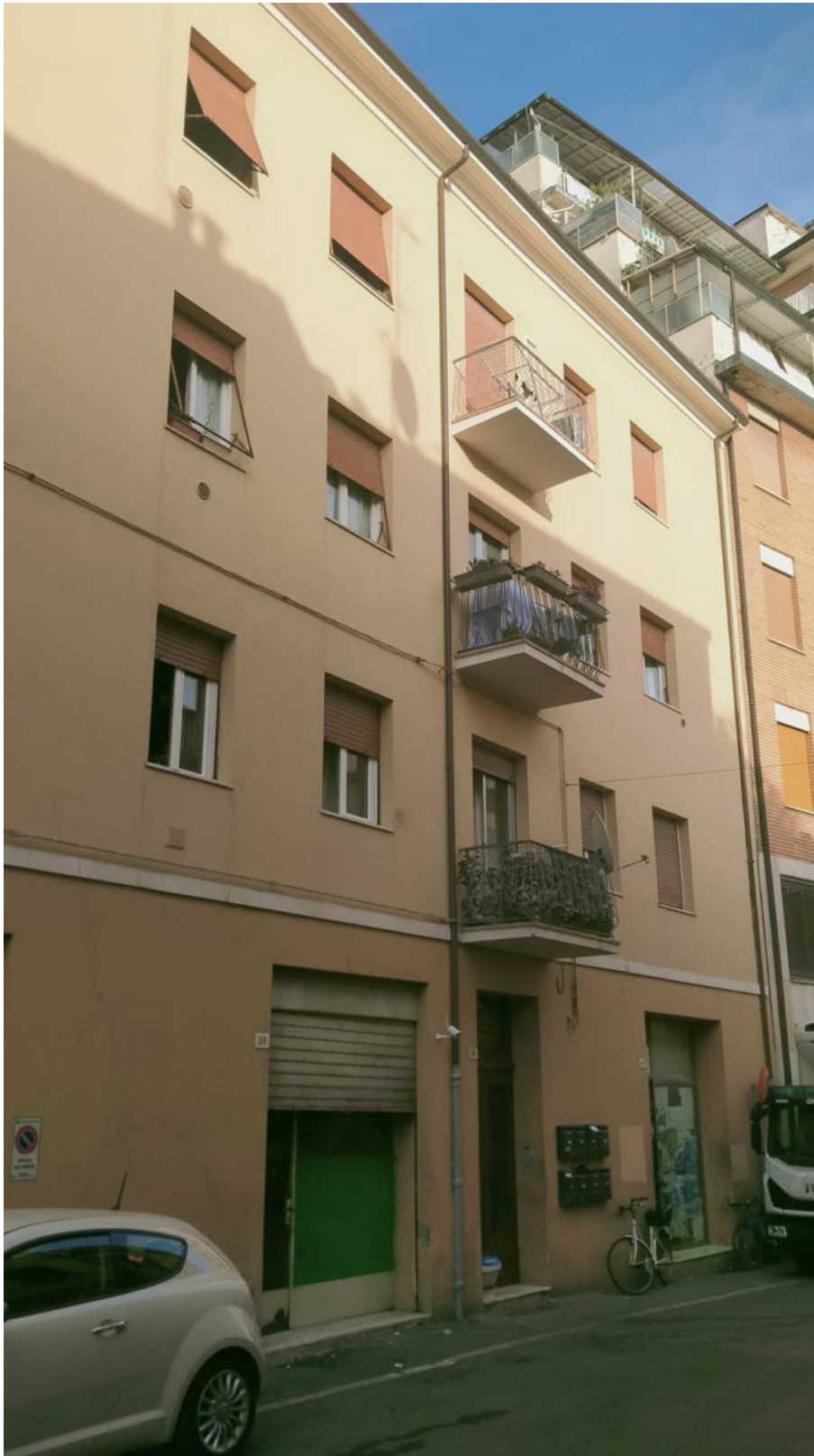
Fot.1 Vista dell'ingresso all'edificio condominiale.
